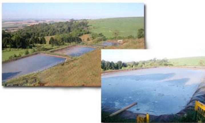
**Figura 10.12 -Aterro Sanitário da empresa CONTINENTAL na cidade de Xanxerê – SC – Sistema de Tratamento dos líquidos percolados**
