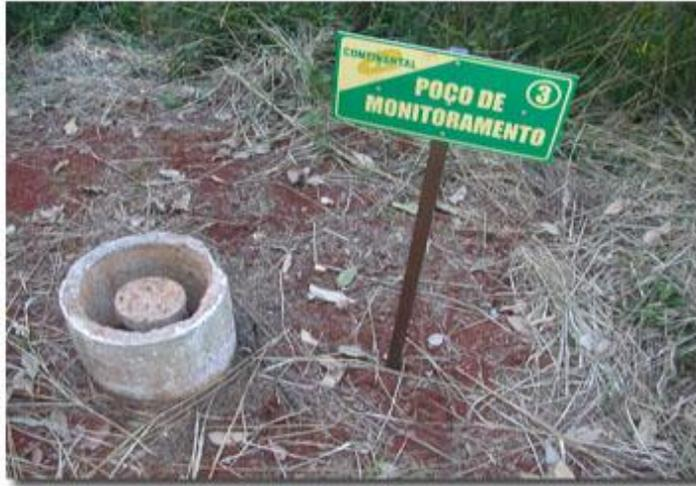
**Figura 10.13 -Aterro Sanitário da empresa CONTINENTAL na cidade de Xanxerê – SC – Poço piezométrico**
