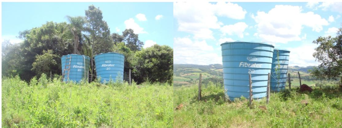
**Figura 8.11 e 8.12 – Reservatórios “B” em fibra de vidro de 20 m<sup>3</sup>**
