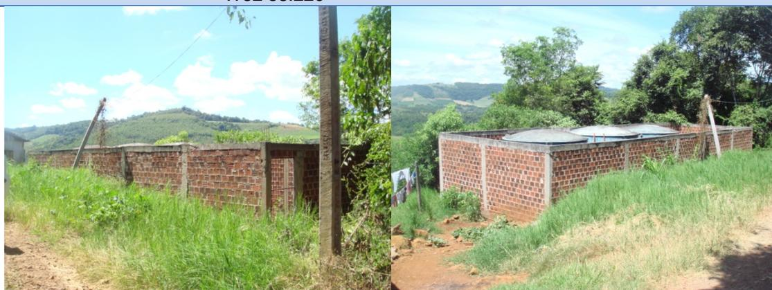
**Figura 8.9 e 8.10 – Reservatório "A" em caixas de fibra de 15m<sup>3</sup>**
