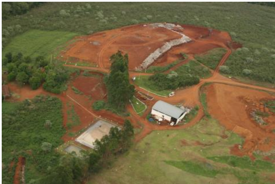
Figura 10.10 -Aterro Sanitário da empresa TUCANO na cidade de Saudades/SC.
