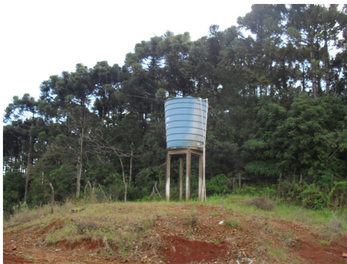
Figura 8.6 – Reservatório “B” de fibra de 20m 3 para abastecimento da cidade de Serra alta/SC, junto ao antigo abatedouro.
