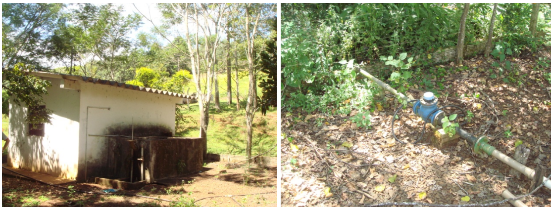
Figura 8.26 – Poço profundo 08 desativado – linha Guaporé.
