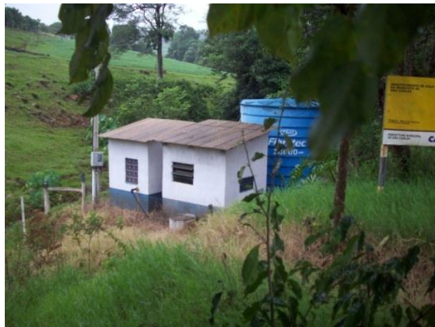
Figura 8.14 – Poço e Reservatório Inferior Linha São João.
