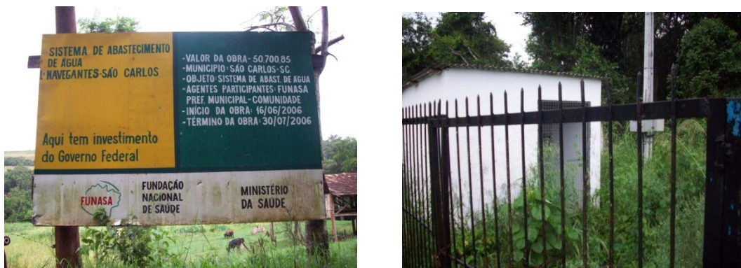
Figura 8.10 e 8.11. – Poço Artesiano – Linha Navegantes
