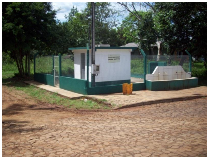
Figura 8.8 – Poço Água Mineral – CASAN
