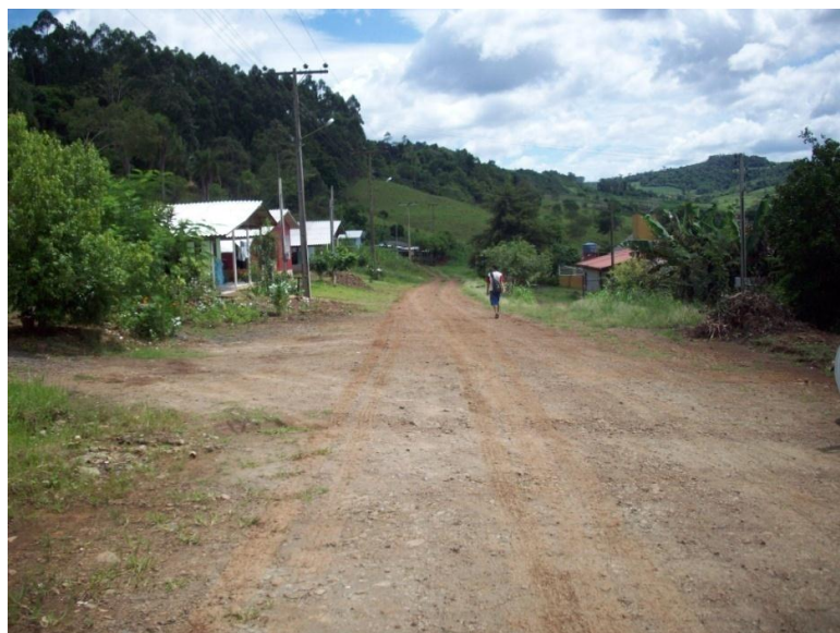
Figura 9.7 – Ausência de drenagem e pavimentação
