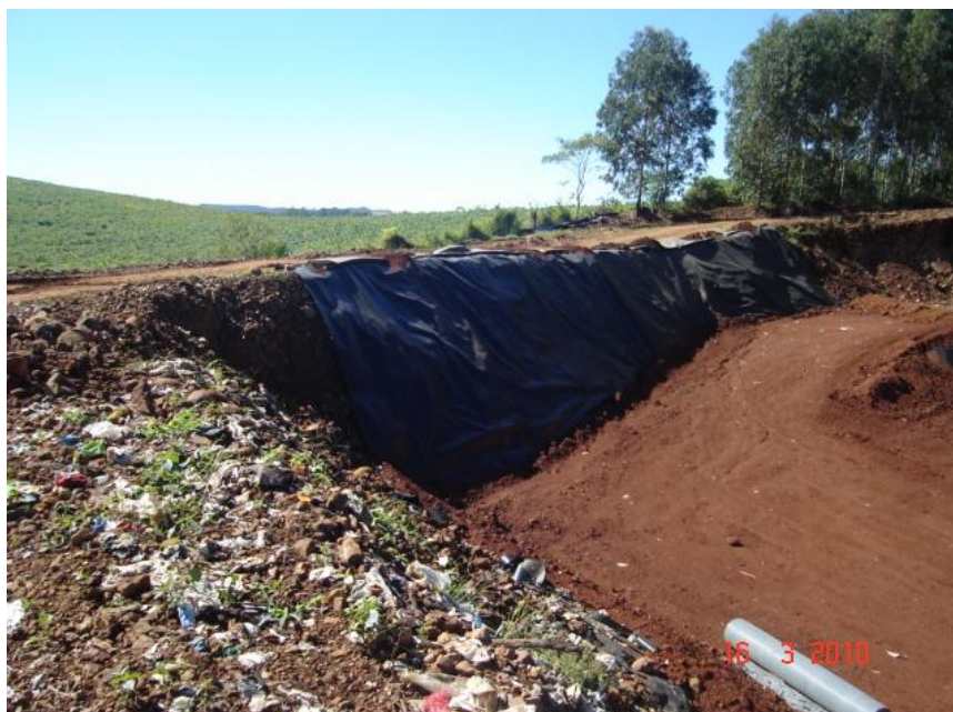
Figura 10.15 - Aterro Sanitário da empresa CONTINENTAL na cidade de Xanxerê – SC – Disposição final
