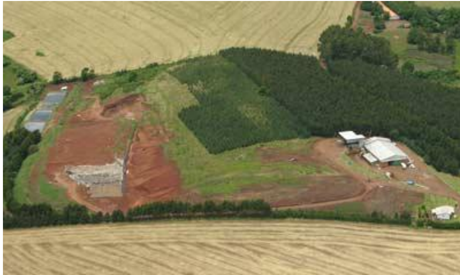
Figura 10.9 - Aterro Sanitário da empresa CONTINENTAL na cidade de Xanxerê – SC
