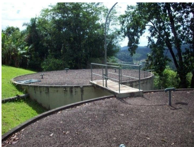
Figura 8.7 – Reservatórios de Montante localizados na ETA.
