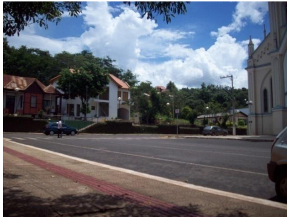
Figura 9.5– Rua Padre Anchieta, galeria de macro drenagem.
