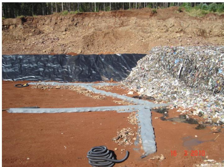
**Figura 10.11 -Aterro Sanitário da empresa CONTINENTAL na cidade de Xanxere – SC – Sistema de Drenagem**
