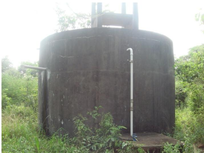
**Figura 8.5 – Reservatório “A” de 50m<sup>3</sup>**
