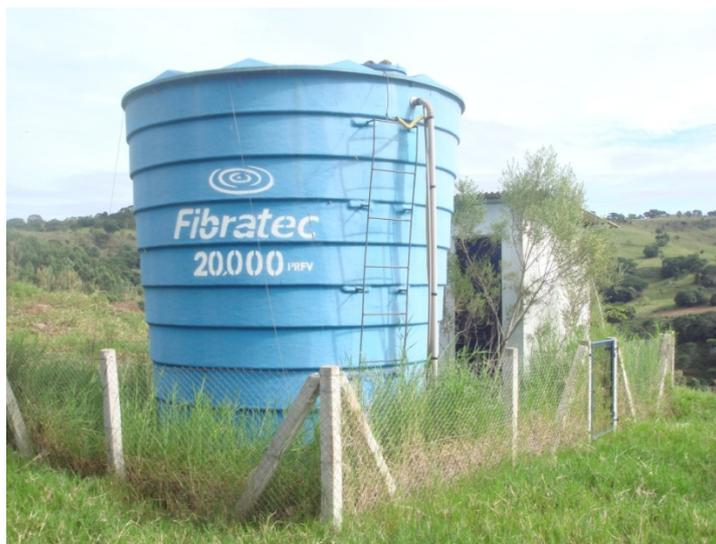
**Figura 8.4 – Reservatório “B” de 20m<sup>3</sup>**
