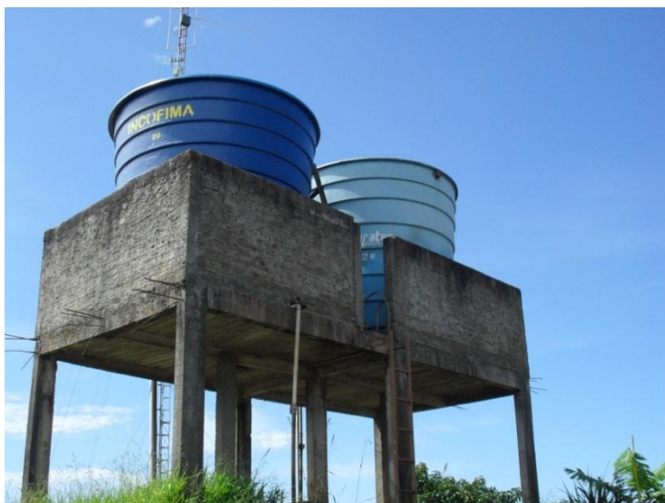
Figura 8.10 - Reservatórios de Água
