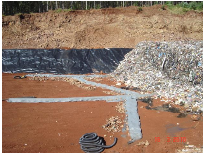
Figura 11.8. -Aterro Sanitário da empresa CONTINENTAL na cidade de Xanxere – SC – Sistema de Drenagem
