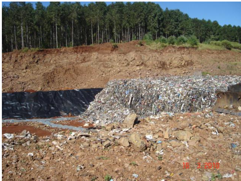
Figura 11.11. -Aterro Sanitário da empresa CONTINENTAL na cidade de Xanxere – SC – Disposição final
