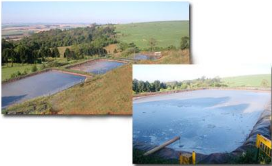
Figura 11.9. - Aterro Sanitário da empresa CONTINENTAL na cidade de Xanxere – SC – Sistema de Tratamento dos líquidos percolados
