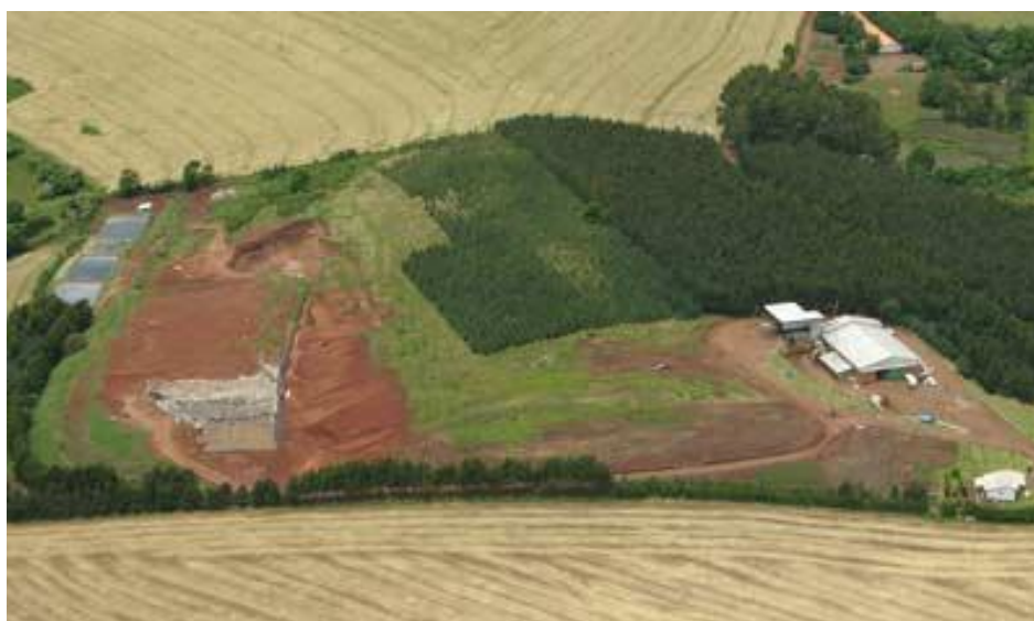
Figura 11.7. - Aterro Sanitário da empresa CONTINENTAL na cidade de Xanxerê – SC
