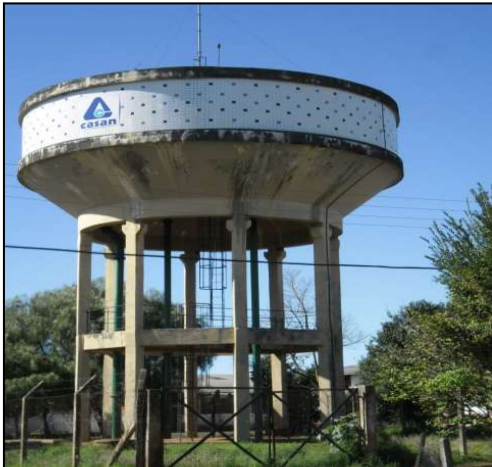
Figura 5: Reservatório CASAN - Bairro Maria Terezinha
