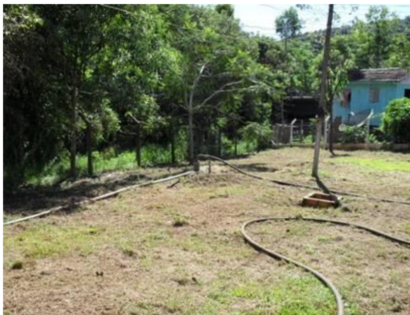
Figura 8.1 – Poço artesiano ETA – Nova Itaberaba.
