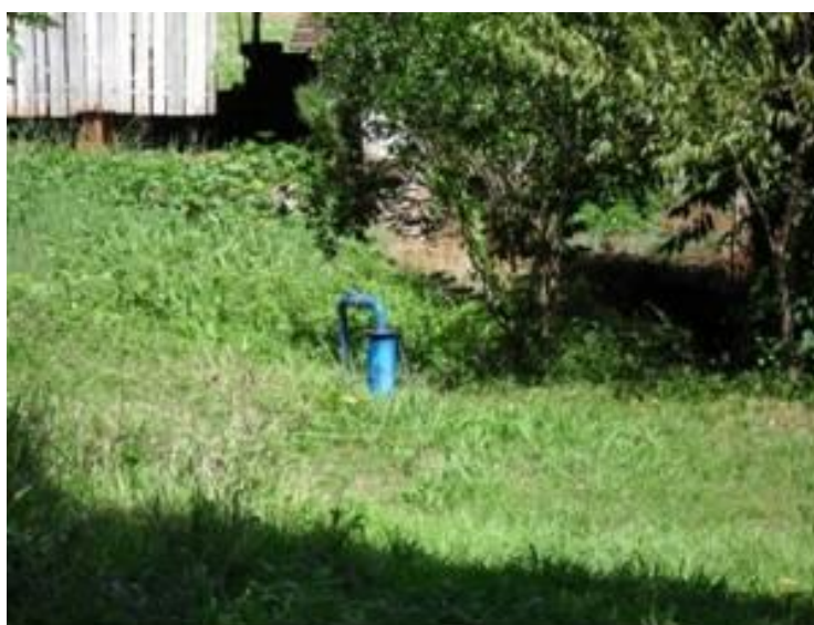
Figura 8.10 – Poço artesiano linha Garibaldi.
