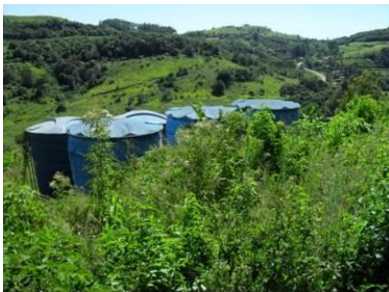
Figura 8.7 – Reservatório de água tratada.
