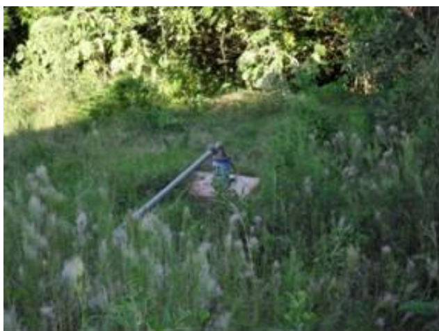
Figura 8.22 - Poço artesiano linha União da Serra.
