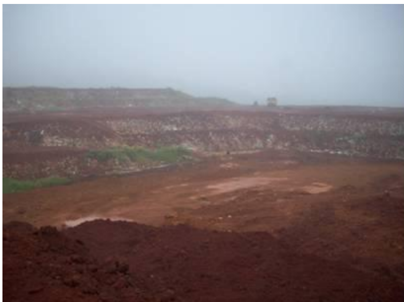
Figura 11.1 – Aterro sanitário, Tucano Obras e Serviços Ltda. Localizado em Saudades – SC.
