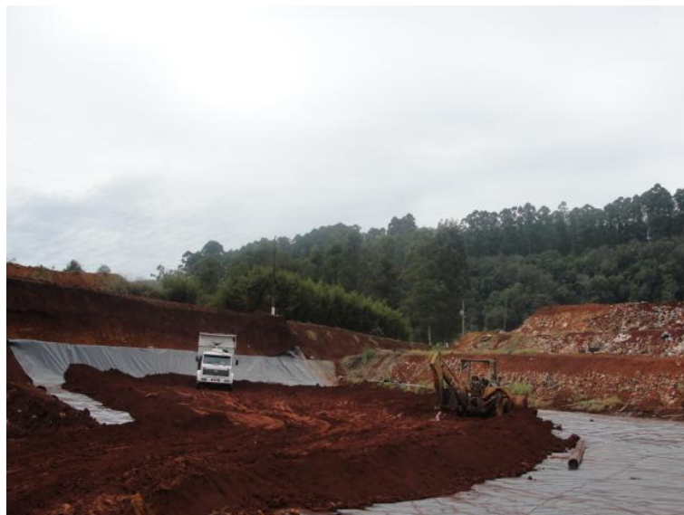
Foto 19 - Aplicação de geomembrana
