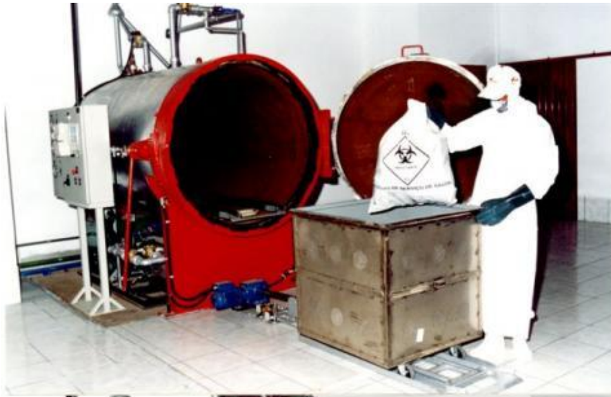
Foto 22- Autoclave empresa Tucano – Fonte: Tucano Obras e Serviços
