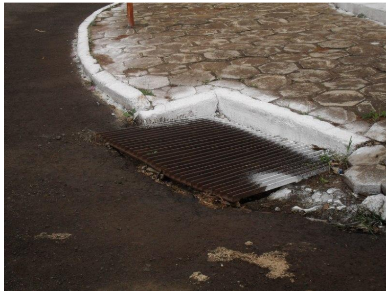
Foto 23 - Bocas coletoras de Nova Erechim
