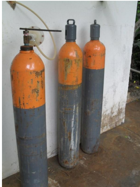
Foto 9 – Cilindros de Cloro Gás
