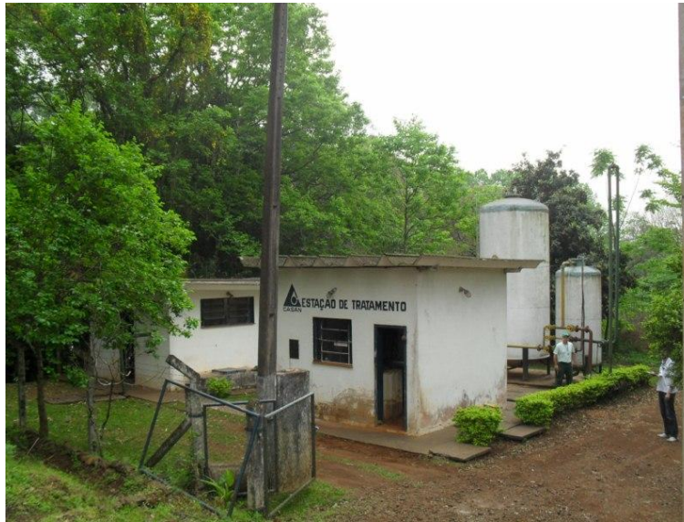
Foto 6 – ETA Compacta Metálica Fechada
