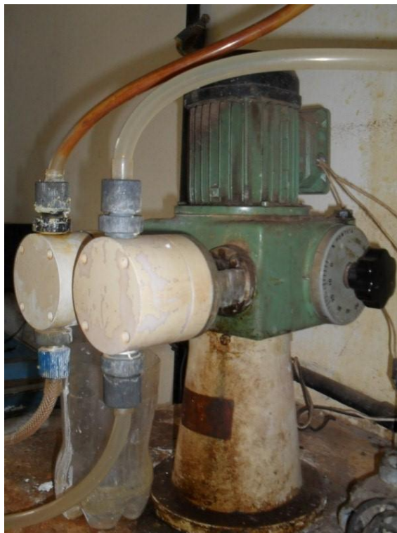
Foto 10 - Dosador de Sulfato e Barília
