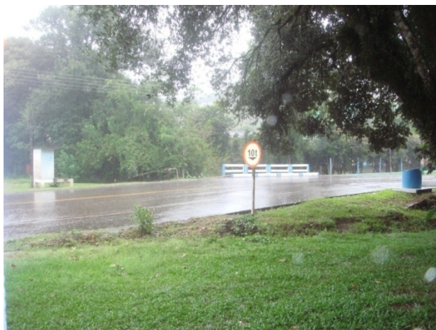
Figura 9.5 – Ponto de inundação – Próximo à praça
