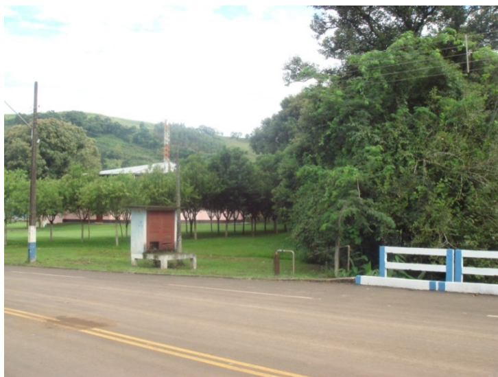
Figura 8.2 - Poço Profundo “A”
