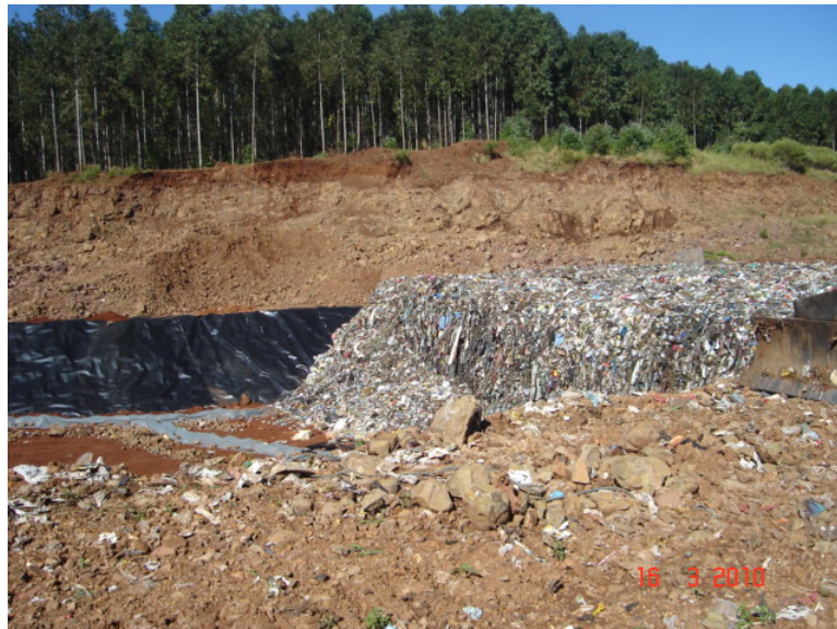
Figura 10.15 -Aterro Sanitário da empresa CONTINENTAL na cidade de Xanxere – SC – Disposição final
