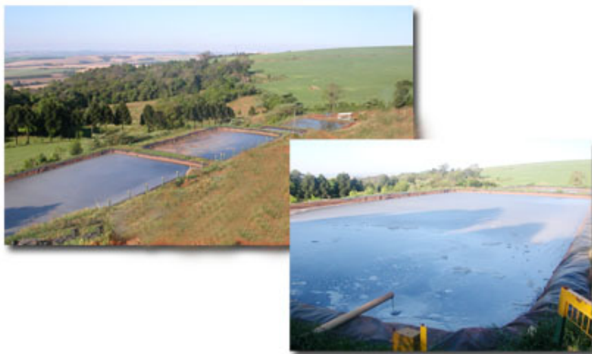
Figura 10.12 e 10.13 -Aterro Sanitário da empresa CONTINENTAL na cidade de Xanxere – SC – Sistema de Tratamento dos líquidos percolados
