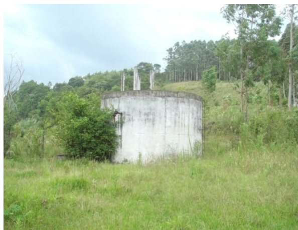
Figura 8.6 – Reservatório “C” concreto armado de 70m 3
