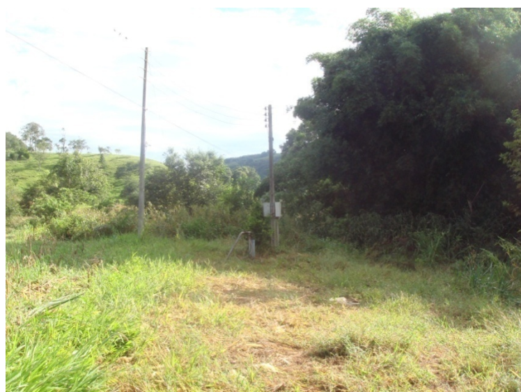
Figura 8.3 - Poço Profundo “B”
