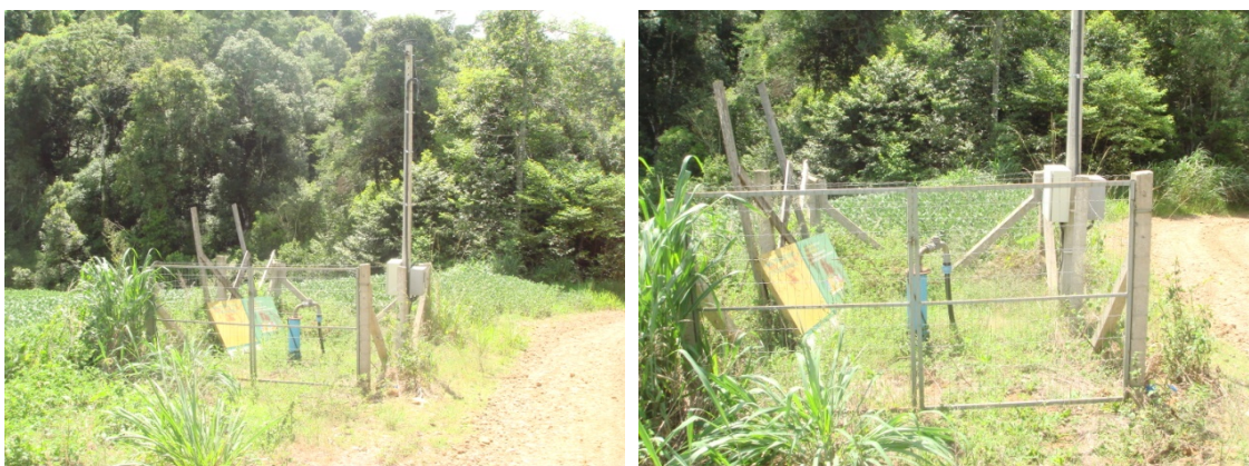
Figura 8.25 – Poço profundo – linha Água limpa
