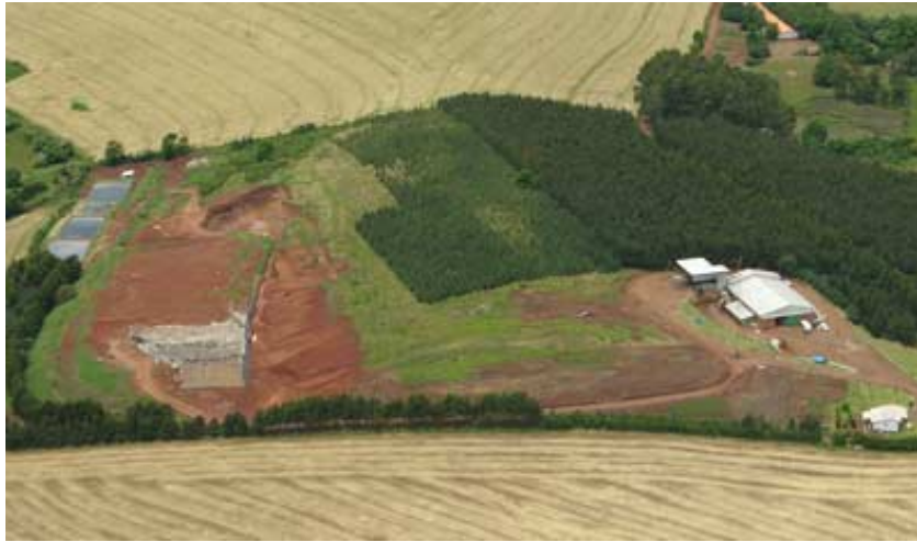
Figura 10.10 -Aterro Sanitário da empresa CONTINENTAL na cidade de Xanxere – SC
