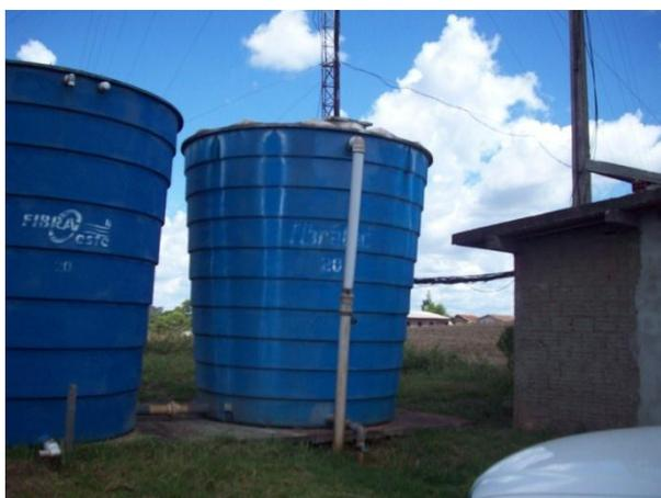
**Figura 8.3 – Reservatório R-1 e R-2 CASAN (Pretensão de se Tornar Elevado).**
