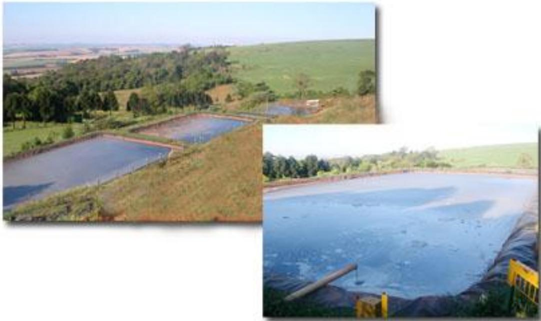
**Figura 11.10 e 11.11 -Aterro Sanitário da empresa CONTINENTAL na cidade de Xanxerê – SC – Sistema de Tratamento dos líquidos percolados.**
