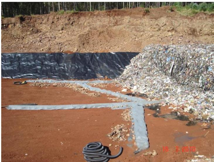
**Figura 11.9 - Aterro Sanitário da empresa CONTINENTAL na cidade de Xanxerê – SC – Sistema de Drenagem**
