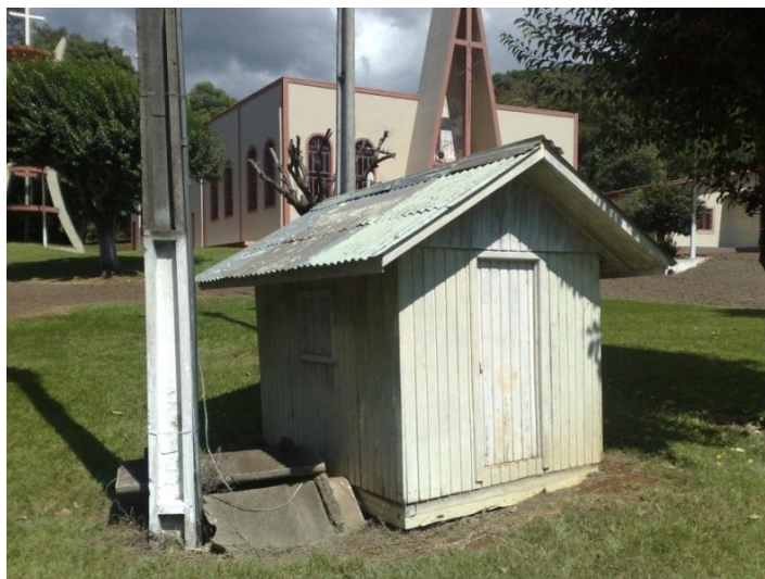
Figura 8.11. – Poço artesiano, linha Fernando Machado.
