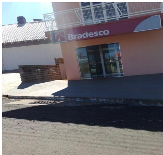
Figura 9.3. – Boca de lobo com odores provenientes de esgoto.
