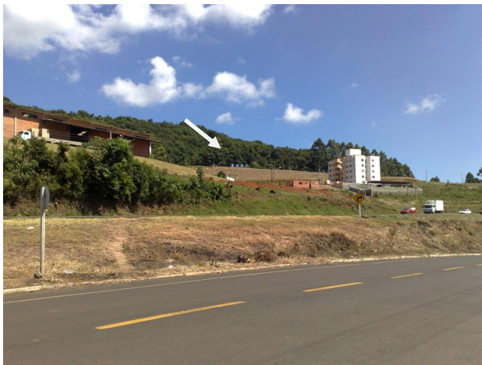
Figura 8.8 – Reservatórios no Bairro Industrial.
