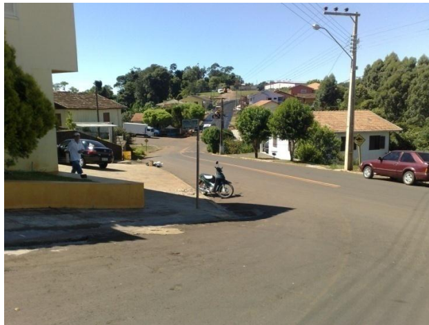
Figura 9.5. – Boca de lobo , em frente a farmácia, com odores provenientes de esgoto.
