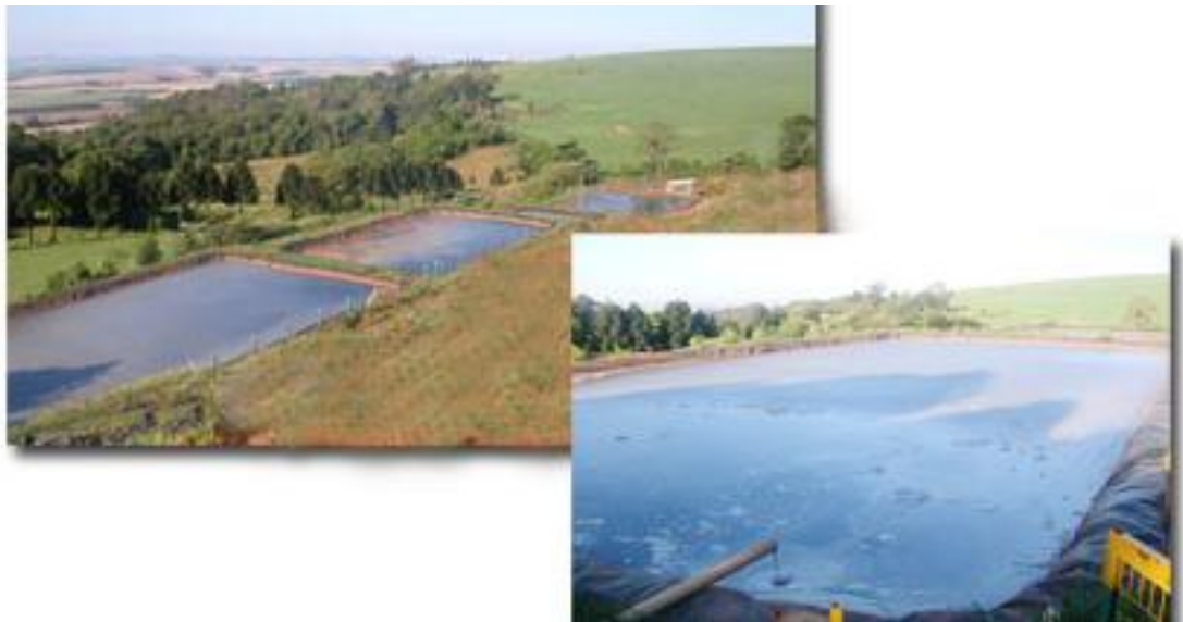
Figura 11.12. - Aterro Sanitário da empresa CONTINENTAL na cidade de Xanxerê – SC – Sistema de Tratamento dos líquidos percolados.
