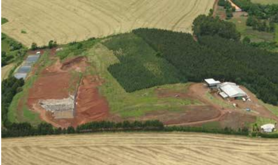
Figura 11.10. - Aterro Sanitário da empresa CONTINENTAL na cidade de Xanxerê – SC
