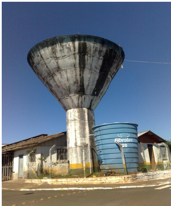
Figura 8.7 – Reservatório elevado perímetro urbano.
