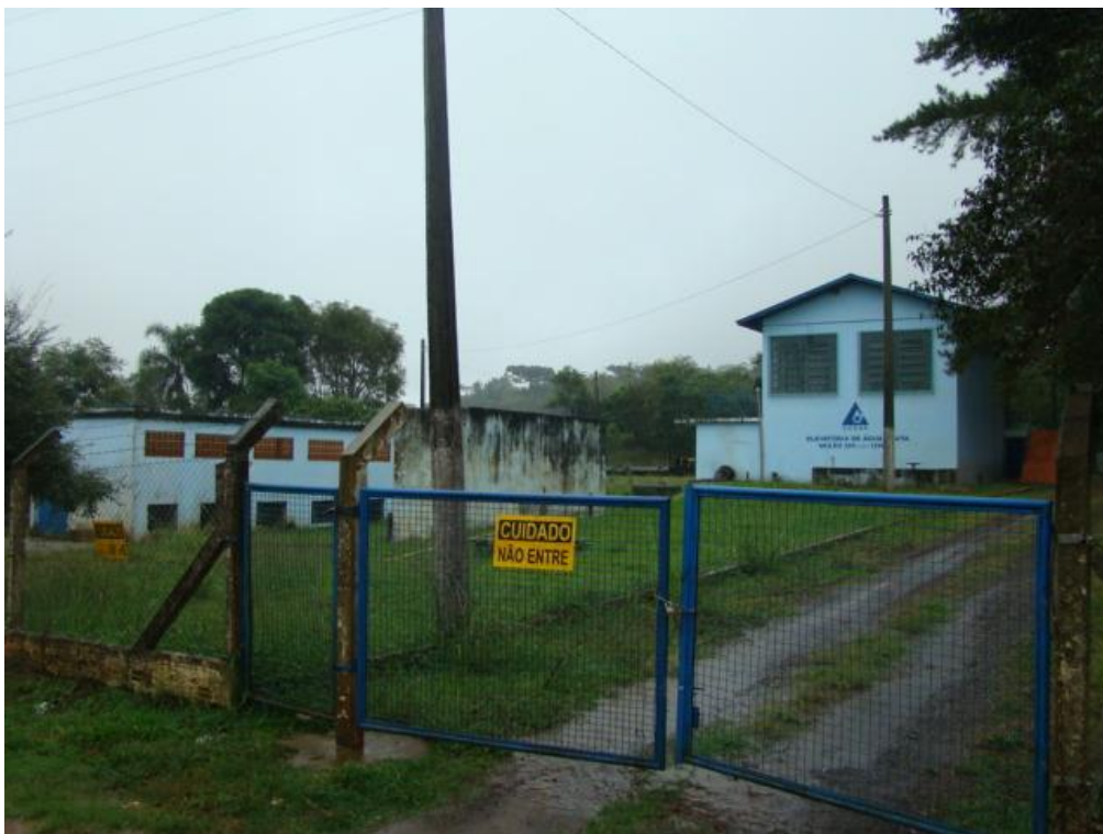
Figura 23: Estação elevatória de água bruta com capacidade entre 360L/s e 440L/s
