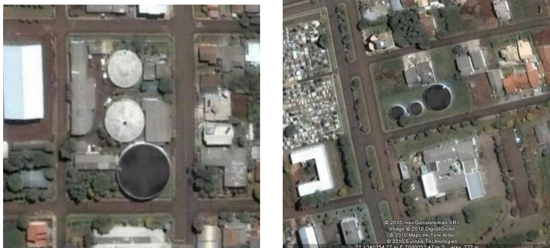
Figura 41: Reservatórios R1 (São Cristóvão) e R2 (Centro)
