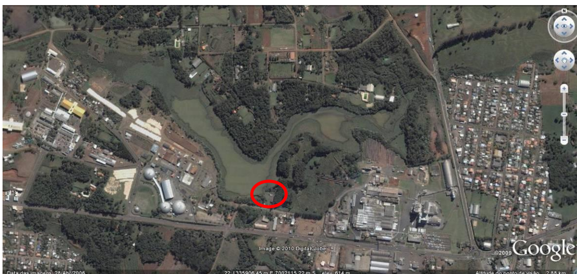
Figura 11: Barragem Engenho Braun no Lajeado São José em meio à ocupação urbana e industrial de Chapecó. Em destaque o ponto de captação com a EEAB (Coordenadas UTM L-335.773 / N-7001.832).
