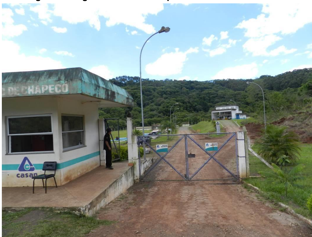
Figura 55: Entrada da ETE de Chapecó
