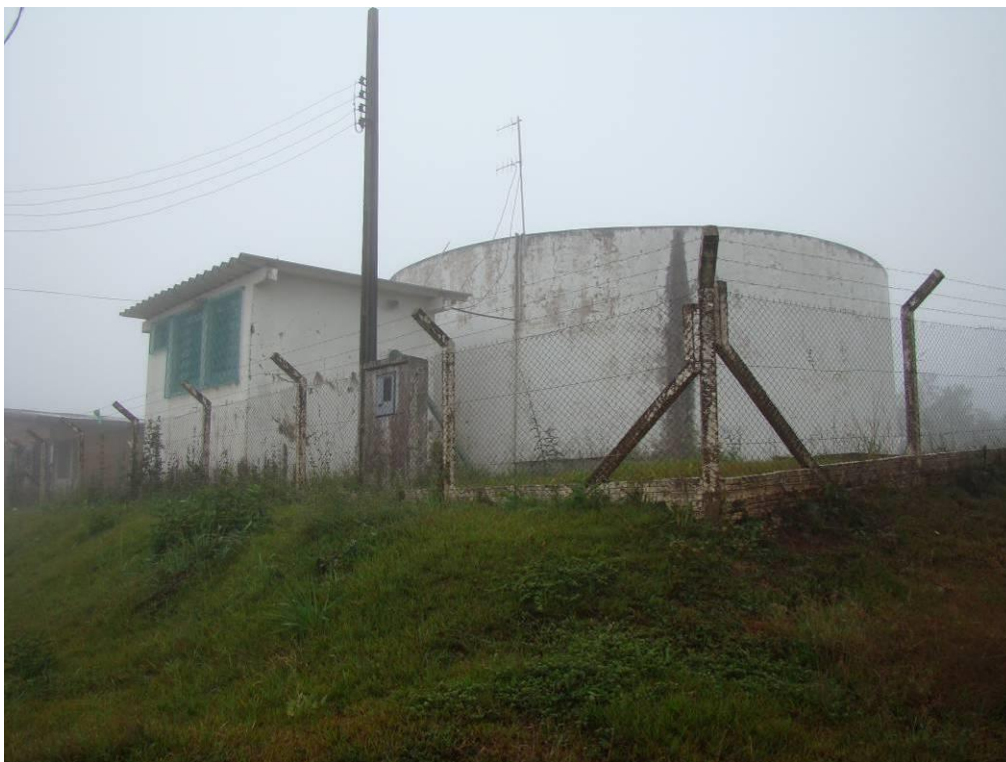
Figura 43: Reservatório no bairro Santa Maria
