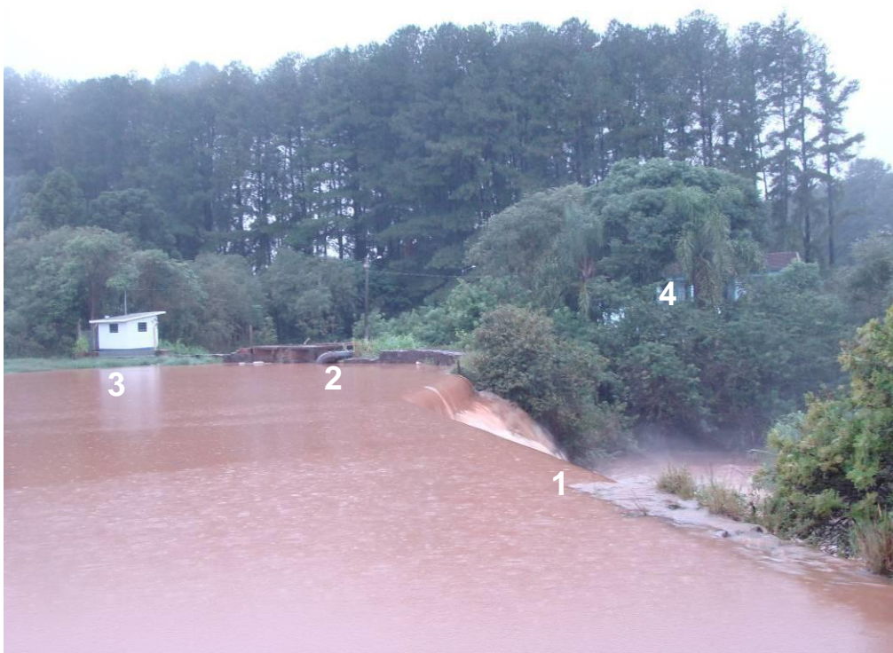
Figura 22: Sistema de captação/adição de água bruta: 1 barragem, 2 captação, 3 casa de máquinas, 4 estação elevatória de água bruta. (Altitude: 609m)
