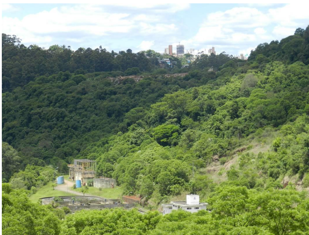
Figura 53: ETE de Chapecó em fundo de vale abaixo da área central
