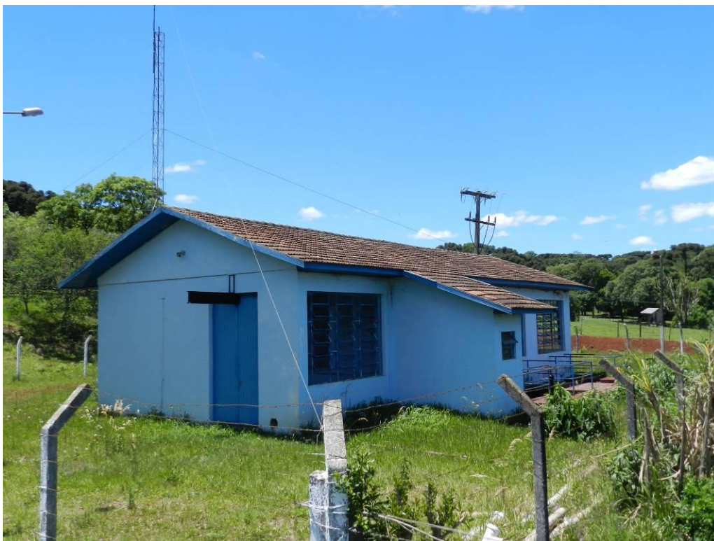
Figura 26: Elevatória na barragem do Lajeado Tigre/Guatambú (Altitude: 540m)
