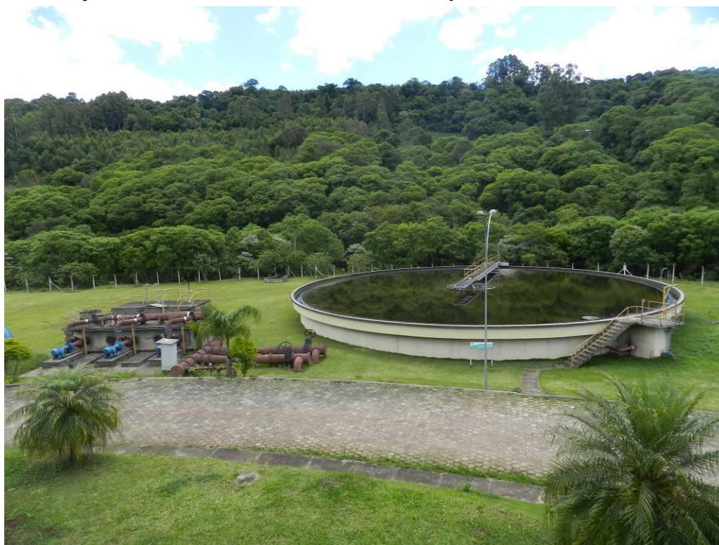
Figura 57: Decantador secundário da ETE de Chapecó
