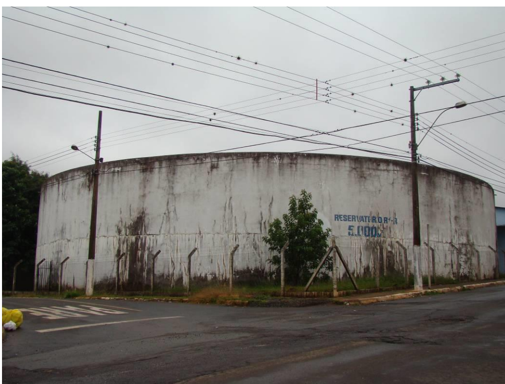
Figura 38: Reservatório principal – R1 com 5.000m 3
