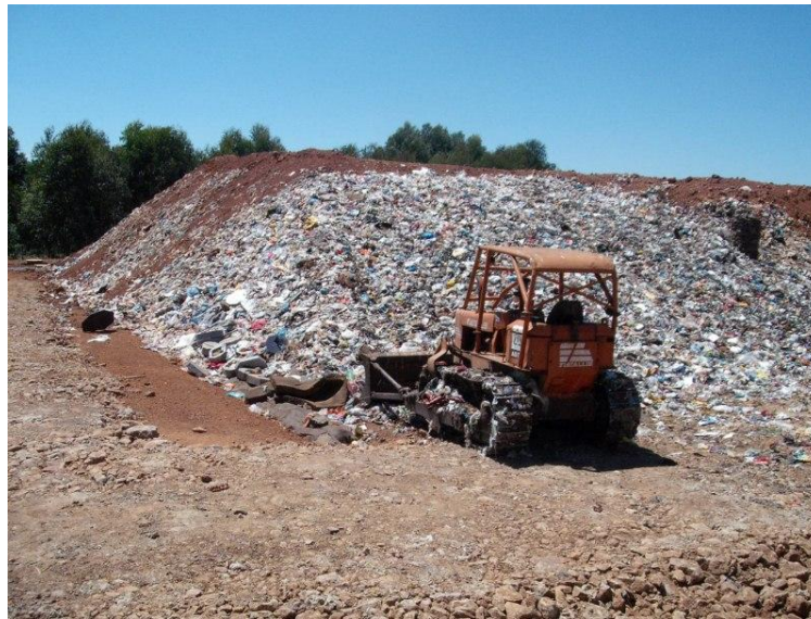
Foto 17 – Equipamento de Compactação
