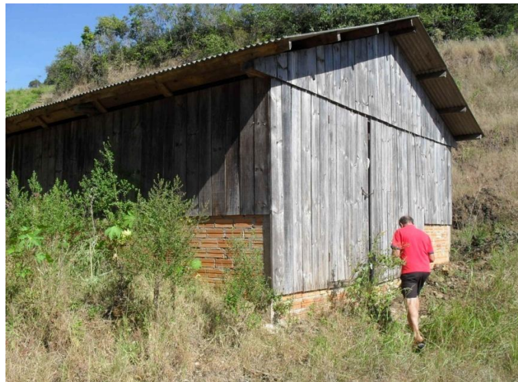
Foto 11 – Edificação de Proteção da Reservação Secundária
