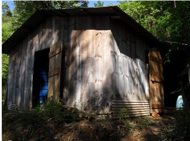
Foto 10 – Conjunto de Reservação Principal
