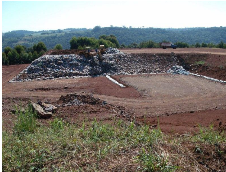
Foto 15 – Vista Geral do Aterro
