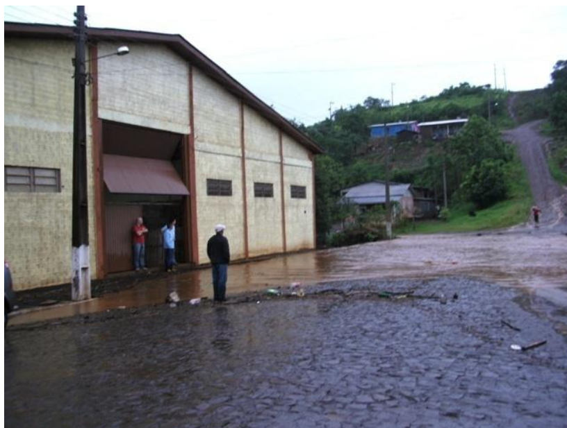
Figura 10.9 – Ponto de alagamento, enchente 29/10/2008.
