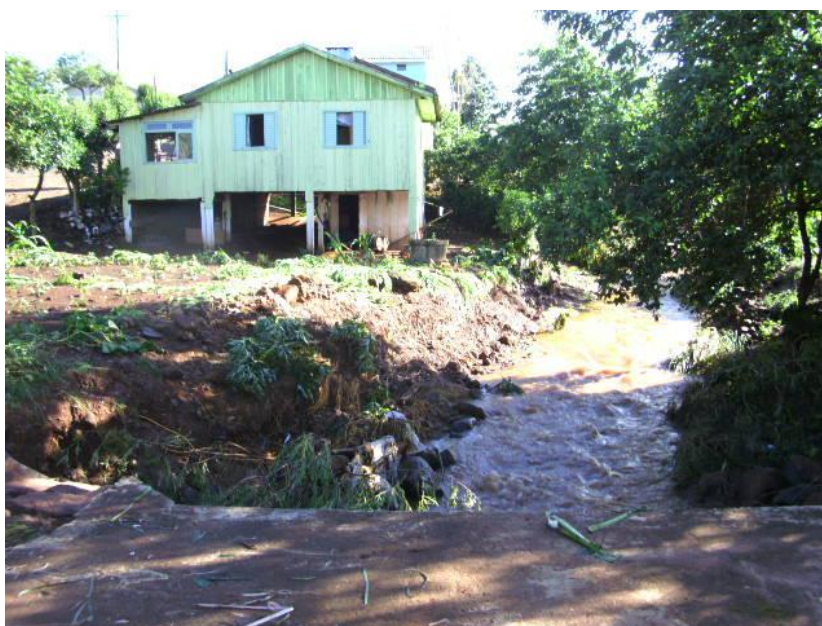
Figura 10.10 – Estragos causados por chuva intensa na data de 11/11/2008.
