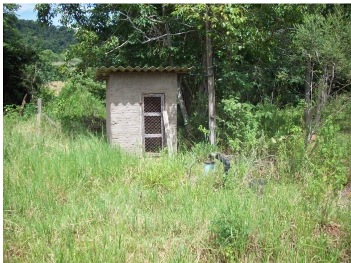
Figura 8.19. – Poço artesiano linha Alto Tarumã. FONTE: Consórcio MPB/ESSE/Sanetal.
