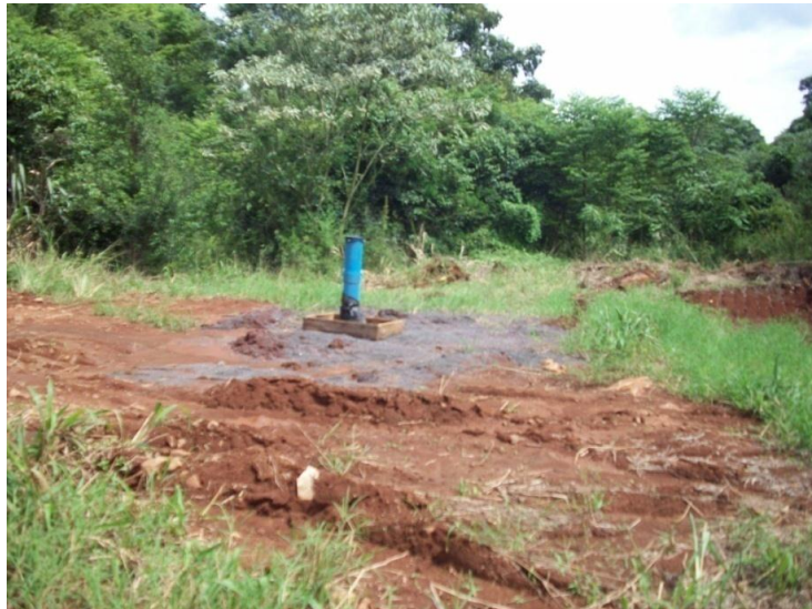
Figura 8.27. – Poço linha São João, a ser instalada a rede. FONTE: Consórcio MPB/ESSE/Sanetal.
