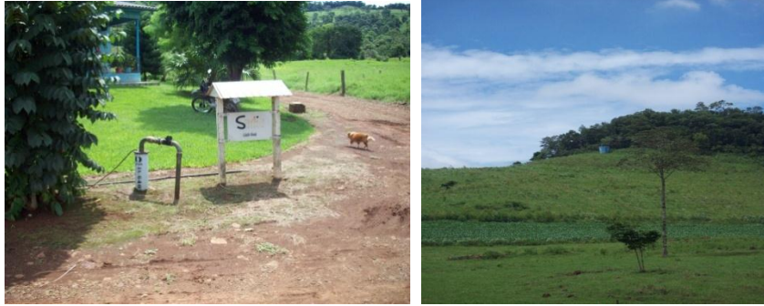
Figura 8.16 e 8.17. – Poço artesiano e reservatório, linha Venci.
