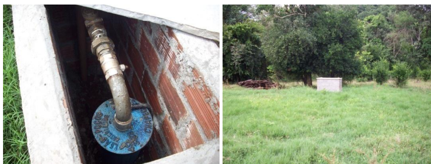
Figura 8.24. e 8.25. – Poço artesiano linha Tarumãzinho.
