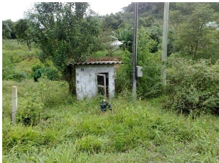
Figura 8.18.- Poço artesiano Linha São João.
