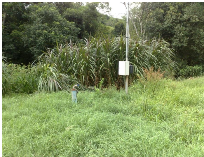
Figura 8.26. – Poço artesiano linha Bonita.
