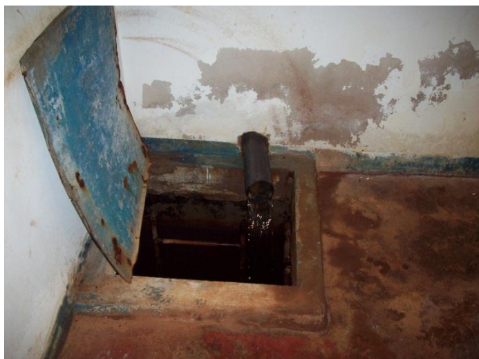
Figura 8.3. – Tubo de adução da água da Fonte Natural – ETA, CASAN.
