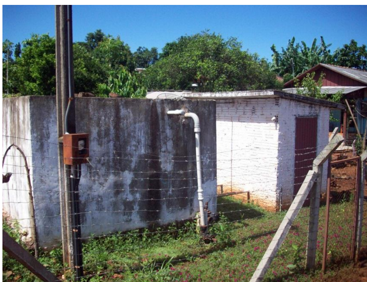
Figura 8.7 – Reservatório e estação de Recalque bairro Antena.
