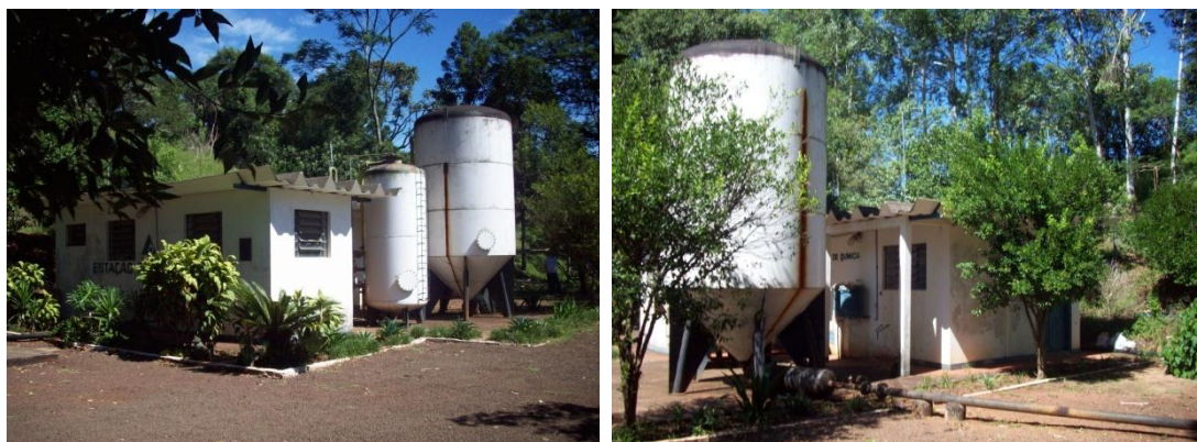
Figura 8.4 e 8.5 – ETA CASAN, linha Laranjeiras.
