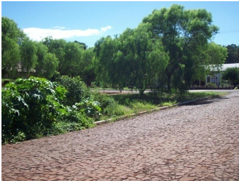
Figura 9.5 – Final da canalização , ponto de alagamento rua Duque de Caxias.
