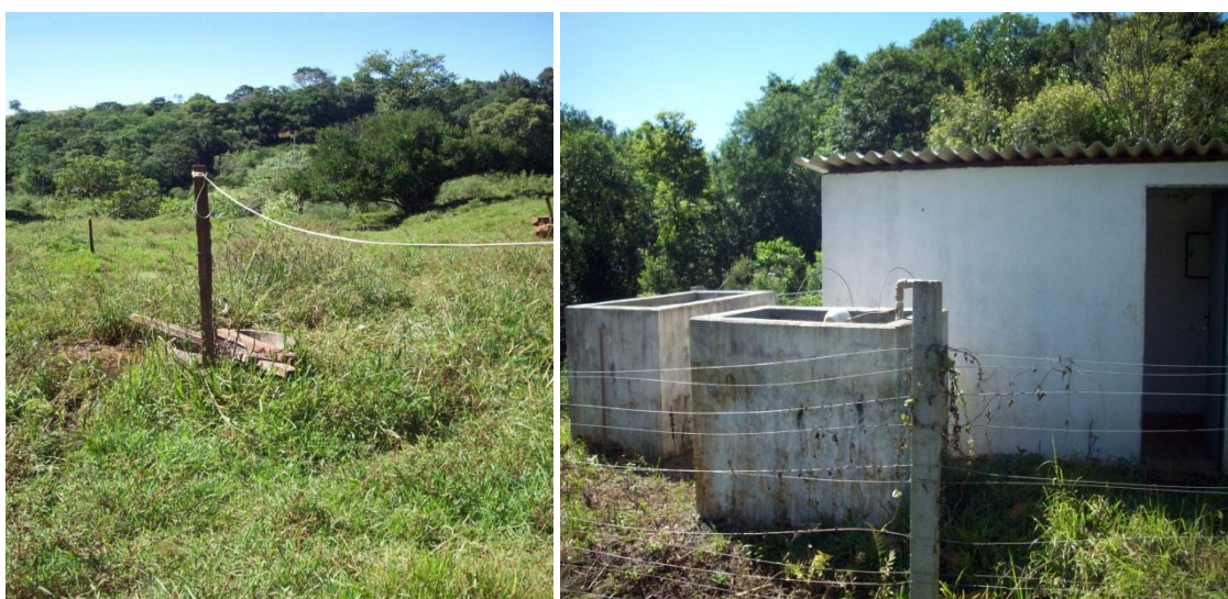
Figura 8.16 e 8.17. – Poço artesiano e ETA, linha São Félix.
