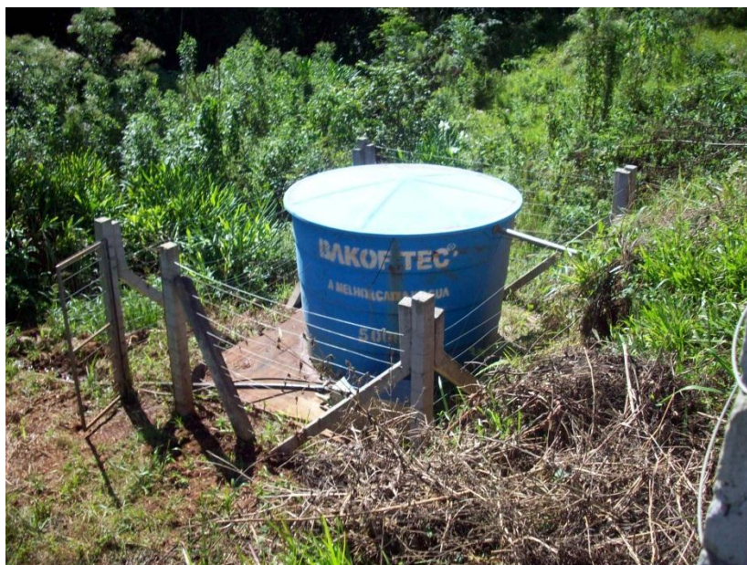
Figura 8.18. - Reservatório Linha São Félix
