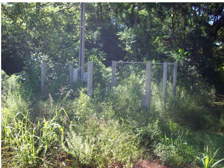
Figura 8.19. – Poço artesiano linha Bonito.
