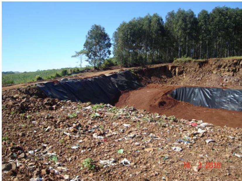
Figura 10.14 - Aterro Sanitário da empresa CONTINENTAL na cidade de Xanxerê – SC – Disposição Final
