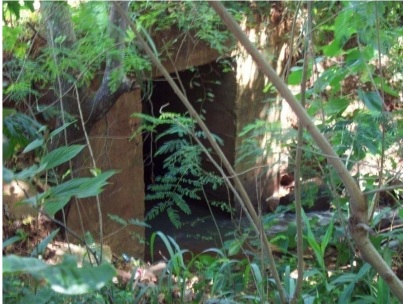
Figura 9.4 – Início da canalização, ponto de alagamento.
