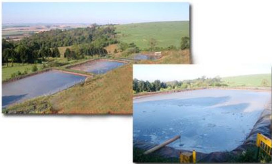
Figura 10.11. - Aterro Sanitário da empresa CONTINENTAL na cidade de Xanxerê – SC – Sistema de Tratamento dos líquidos percolados
