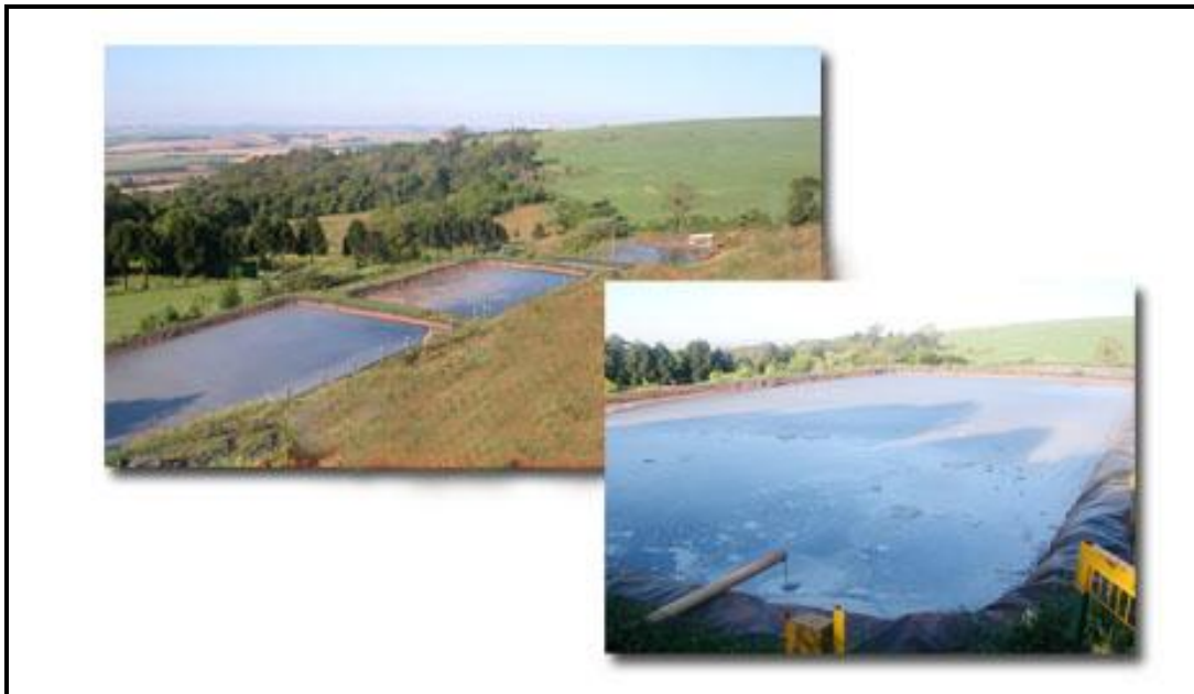
Figura 13: Aterro Sanitário da Empresa Continental- Sistema de Tratamento de líquidos e percolados.
