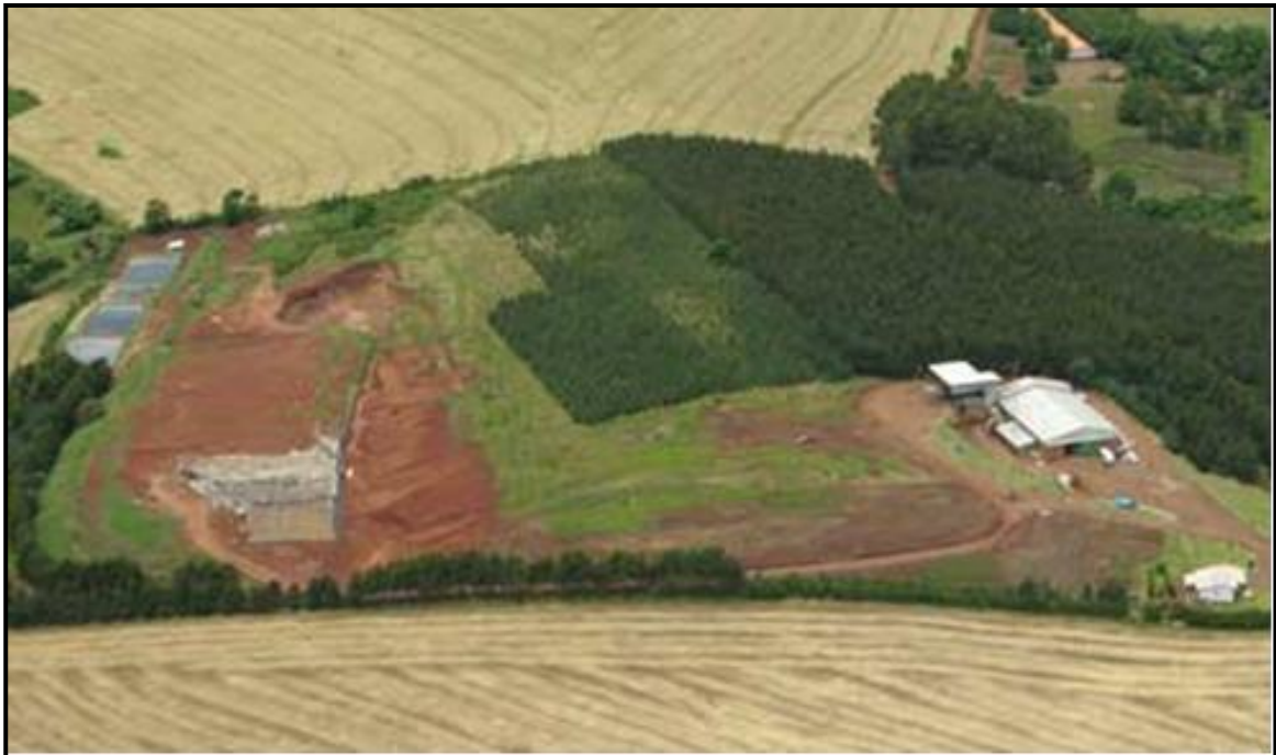
Figura 11: Aterro Sanitário da Empresa Continental em Xanxerê– SC.
