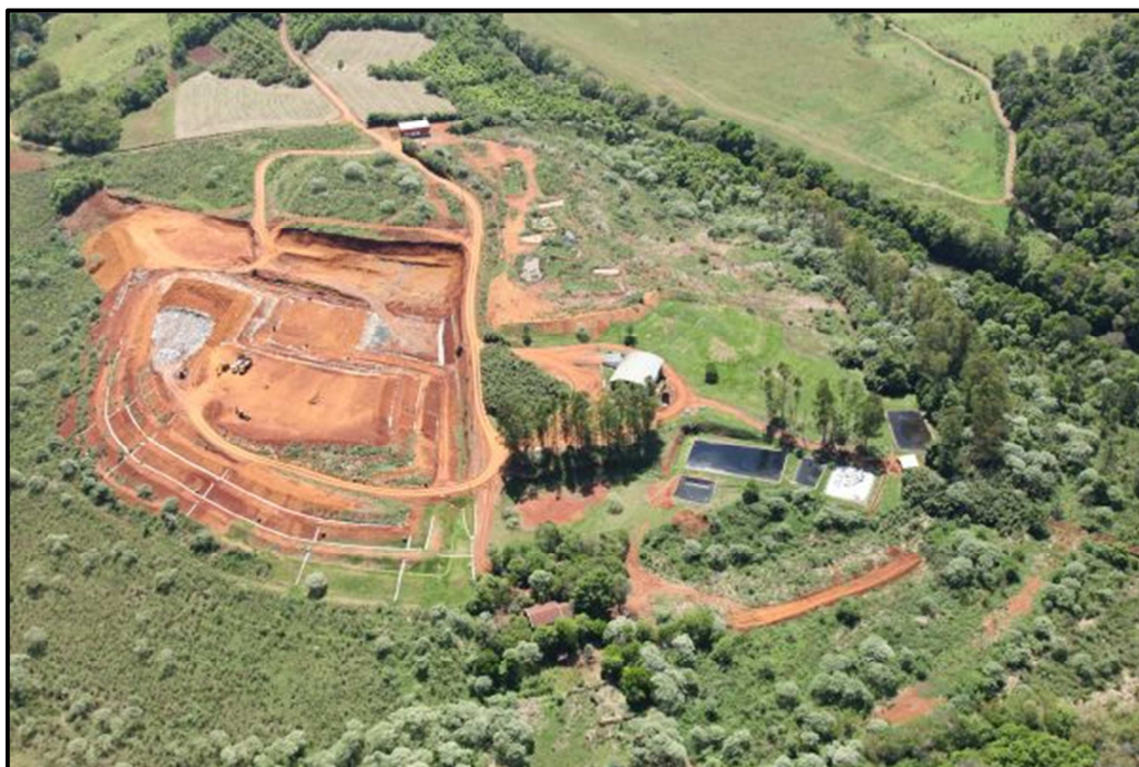
Figura 20: Aterro Sanitário da empresa TUCANO em Saudades – SC
