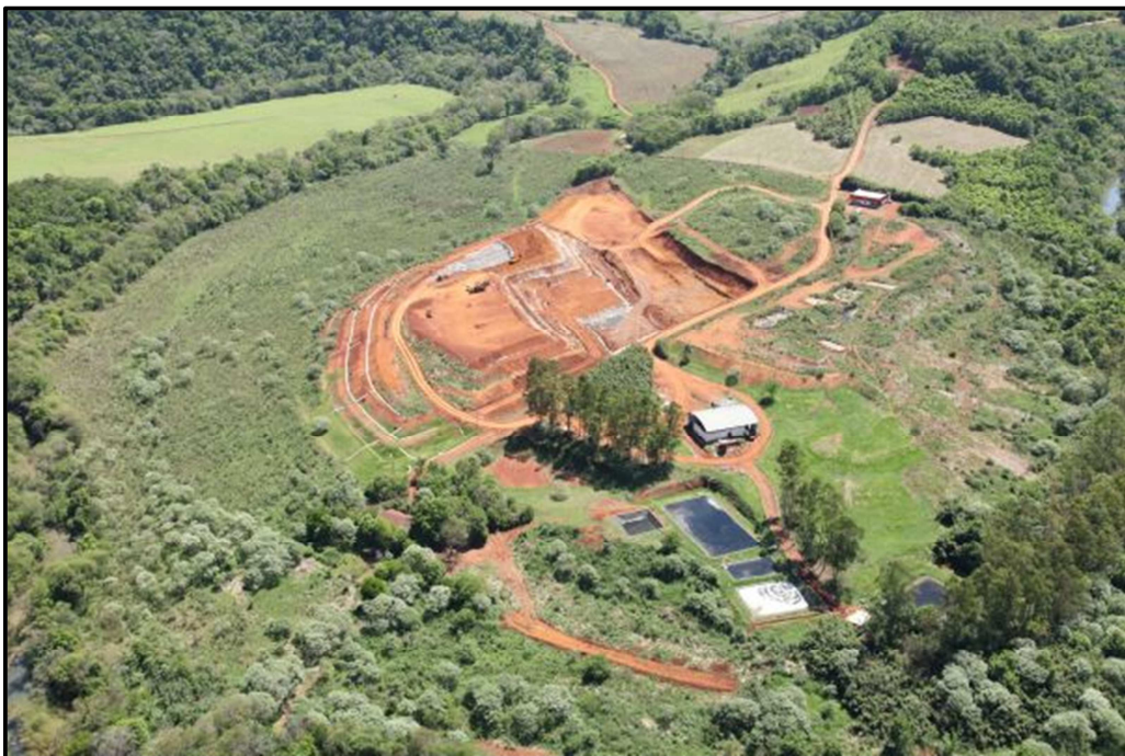
Figura 19: Aterro Sanitário da empresa TUCANO em Saudades – SC
