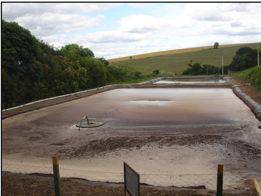
Figura 28: Sistema de tratamento de líquidos percolados
