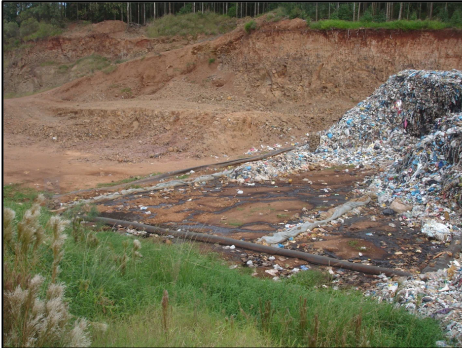
Figura 27: sistema de drenagem de líquidos percolados
