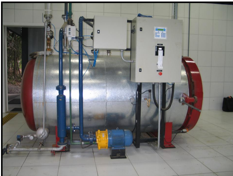
Figura 18: Autoclave da empresa Continental Obras e Serviços Ltda
