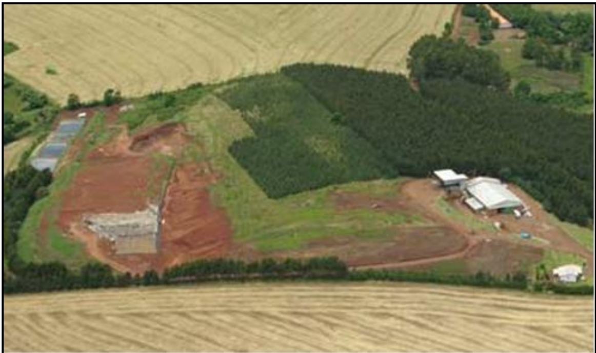
Figura 11: Aterro Sanitário da Empresa Continental em Xanxerê/SC.
