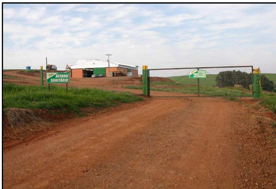
Figura 21: Área coberta de recebimento dos Resíduos - Continental
