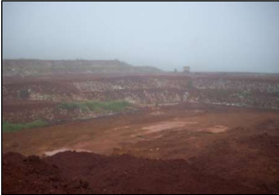
Figura 16: Aterro sanitário da Tucano Obras e Serviços Ltda Saudades – SC.
