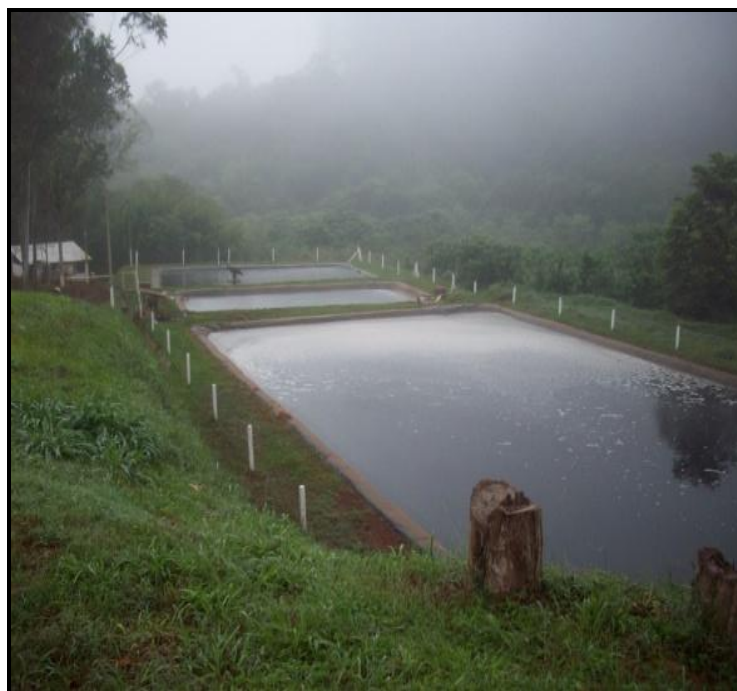
Figura 11: Aterro Sanitário Unidade I Saudades – SC.
