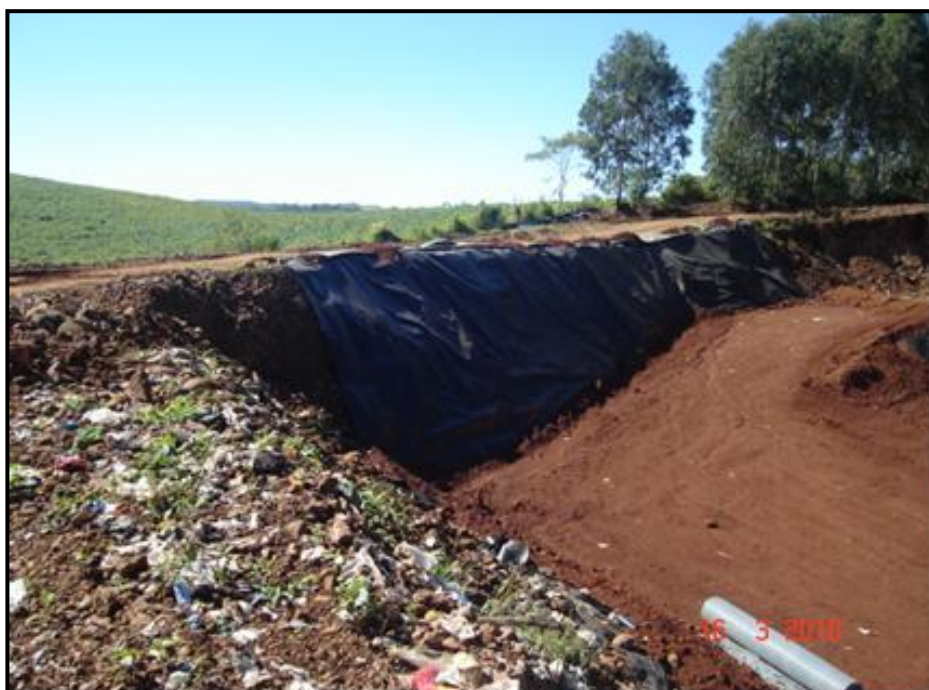
Figura 16: Aterro Sanitário da Empresa Continental – Disposição Final
