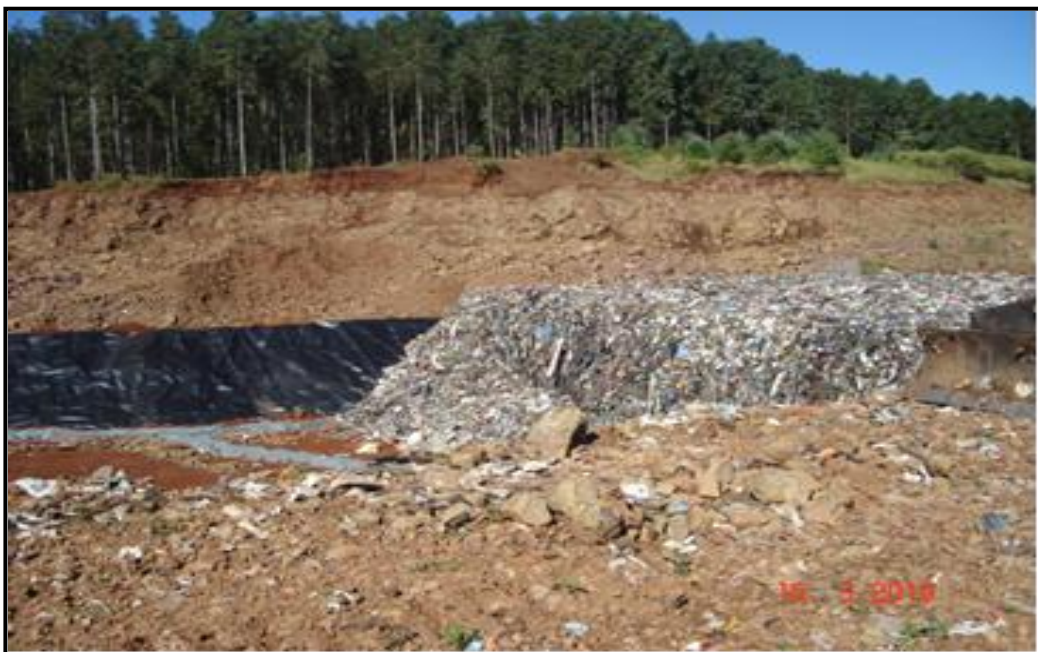
Figura 14: Aterro Sanitário da Empresa Continental – Disposição Final
