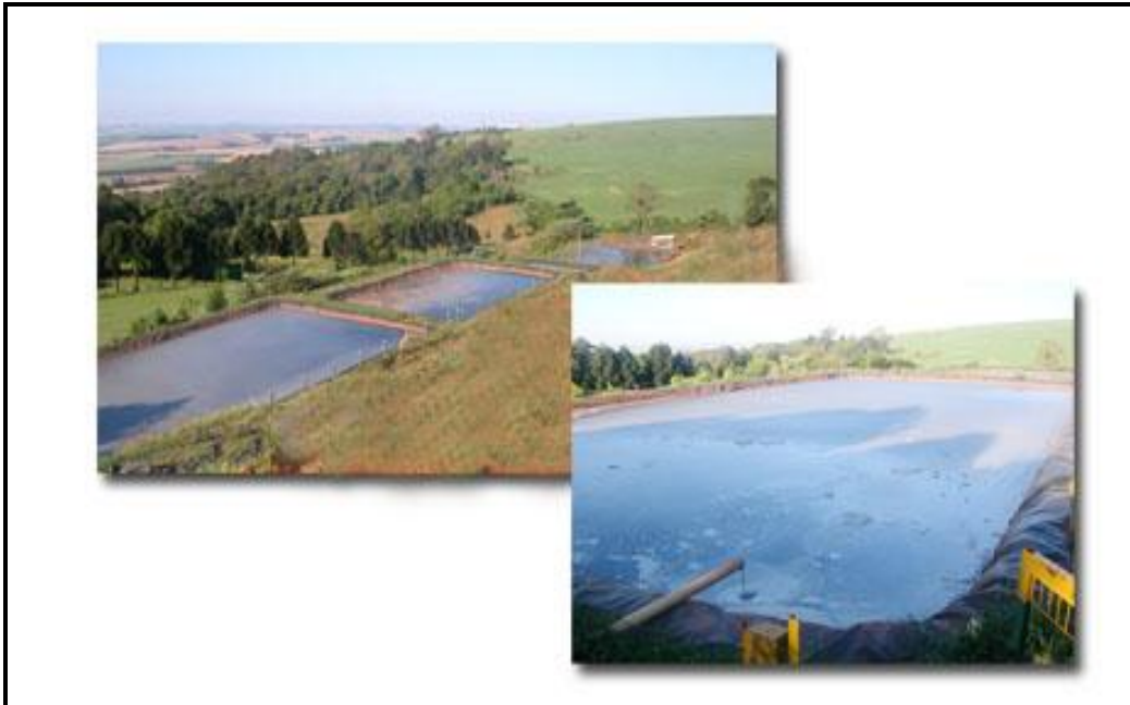
Figura 13: Aterro Sanitário da Empresa Continental - Sistema de Tratamento de líquidos e percolados.
