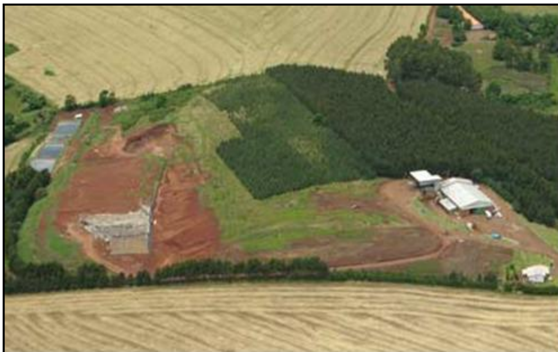
Figura 11: Aterro Sanitário da Empresa Continental em Xanxerê– SC.
