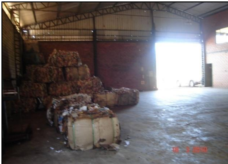
Figura 9: Centro de triagem (depósito lixo reciclável) - Continental
