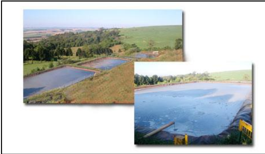
Figura 13: A terra Sanitário da Empresa Continental - Sistema de Tratamento de líquidos e percolados.
