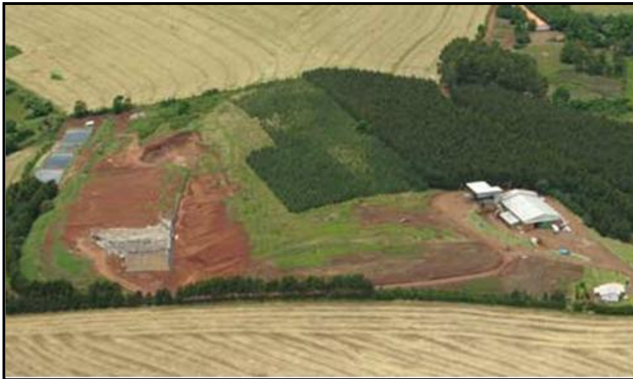
Figura 11: A terro Sanitário da Empresa Continental em Xanxerê- SC. Fonte: PMSB (2011).
