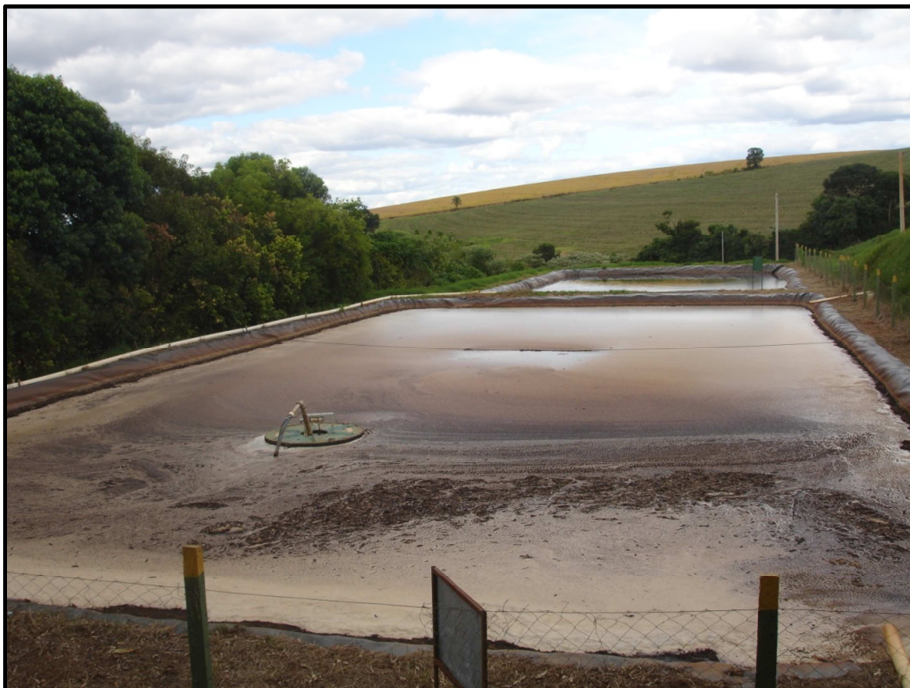
Figura 27: Sistema de tratamento de líquidos percolados
