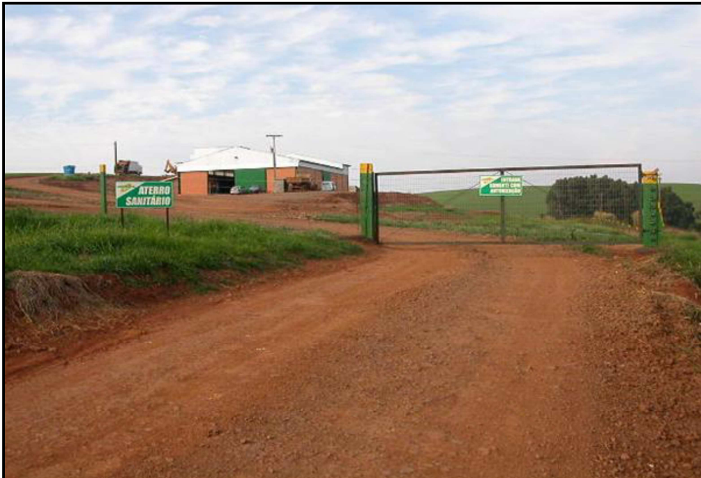
Figura 19: Área coberta de recebimento dos Resíduos
