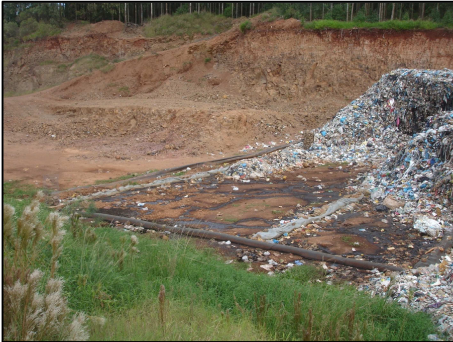
Figura 26: Sistema de drenagem de líquidos percolados
