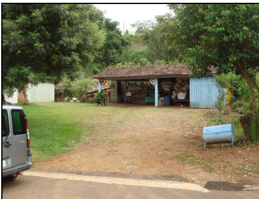
Figura 18: Barracão de depósito de lixo reciclável.
