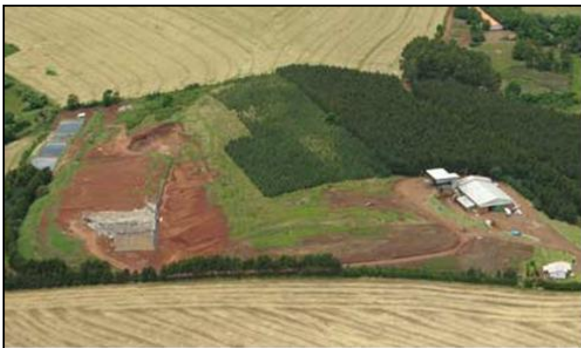
Figura 12: Aterro Sanitário da Empresa Continental em Xanxerê/SC.
