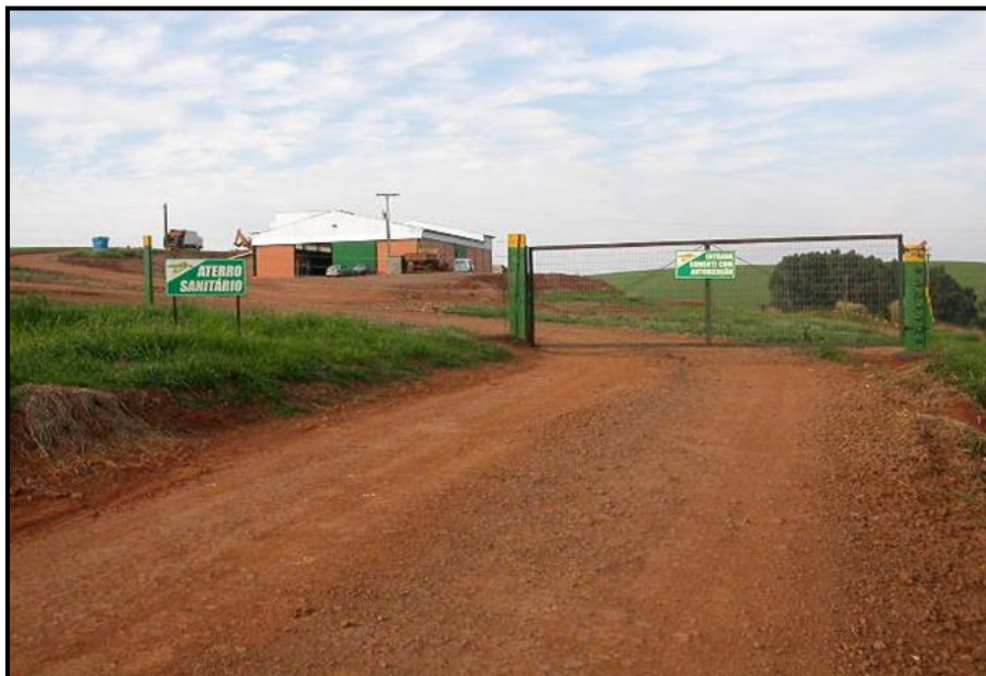
Figura 10: Área coberta de recebimento dos Resíduos - Continental
