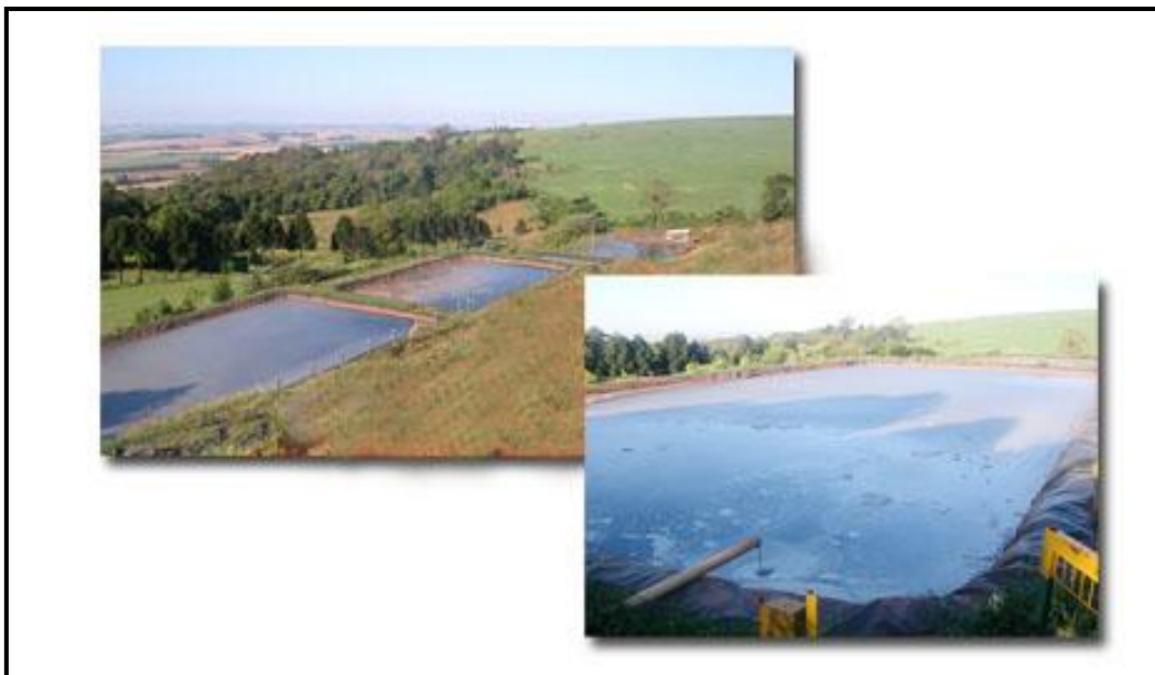
Figura 15: Aterro Sanitário da Empresa Continental- Sistema de Tratamento de líquidos e percolados.
