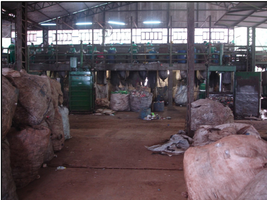
Figura 25: Central de triagem
