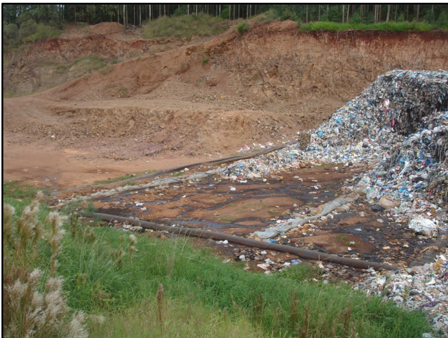
Figura 29: Sistema de drenagem de líquidos percolados
