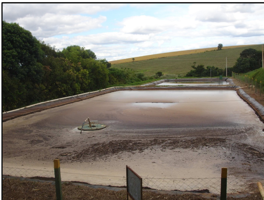
Figura 30: Sistema de tratamento de líquidos percolados
