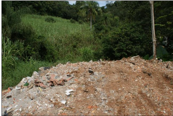
Figura 46 - Aterramento de resíduos da construção civil em Piratuba
