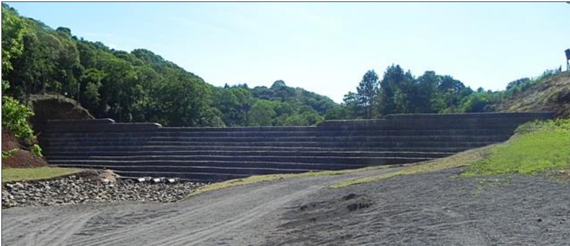
Figura 17 - Barragem de contenção de cheias de Concórdia (Inauguração)
