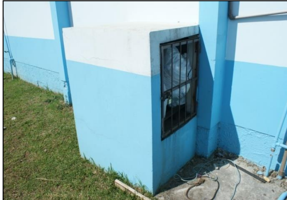
Figura 49 - Inexistência de porta rígida (à esquerda) e resíduos comuns junto aos resíduos de saúde (à direita)
