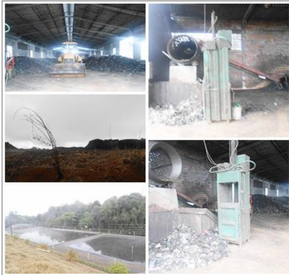
Figura 83 - Dependências do Aterro Sanitário da RONETTRAN
