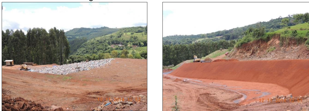
Figura 79 – Área do aterro sanitário CRI
