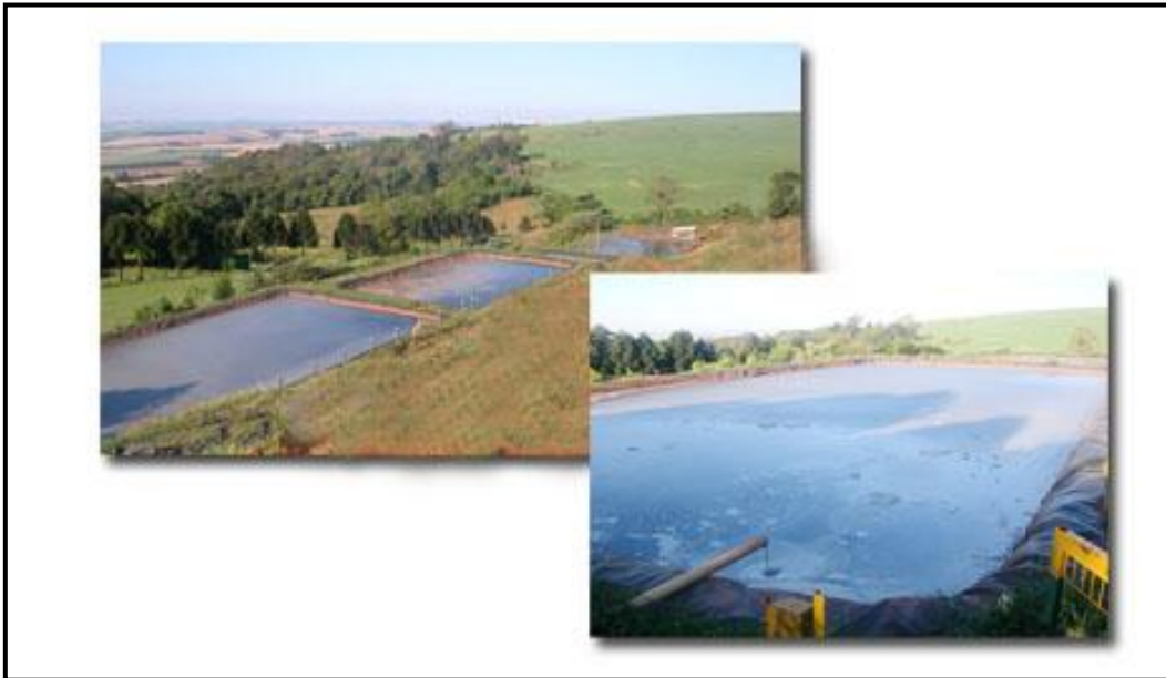
Figura 12: Aterro Sanitário da Empresa Continental - Sistema de Tratamento de líquidos e percolados.
