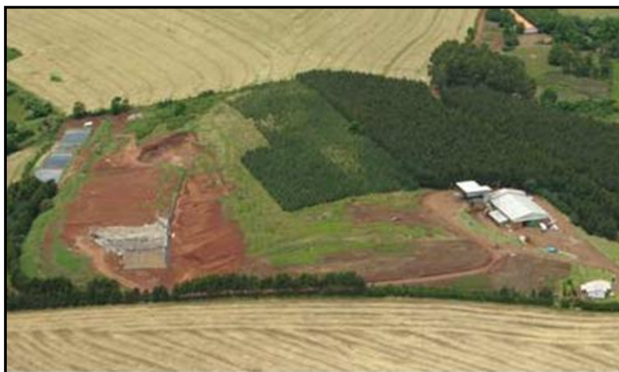
Figura 10: Aterro Sanitário da Empresa Continental em Xanxerê– SC.
