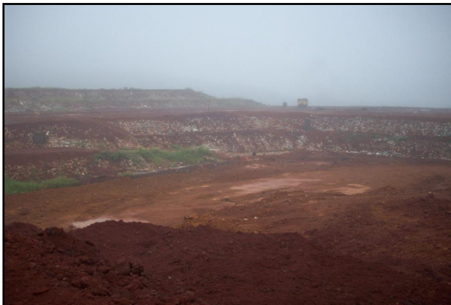
Figura 12: Aterro sanitário, Tucano Obras e Serviços Ltda. Saudades – SC.
