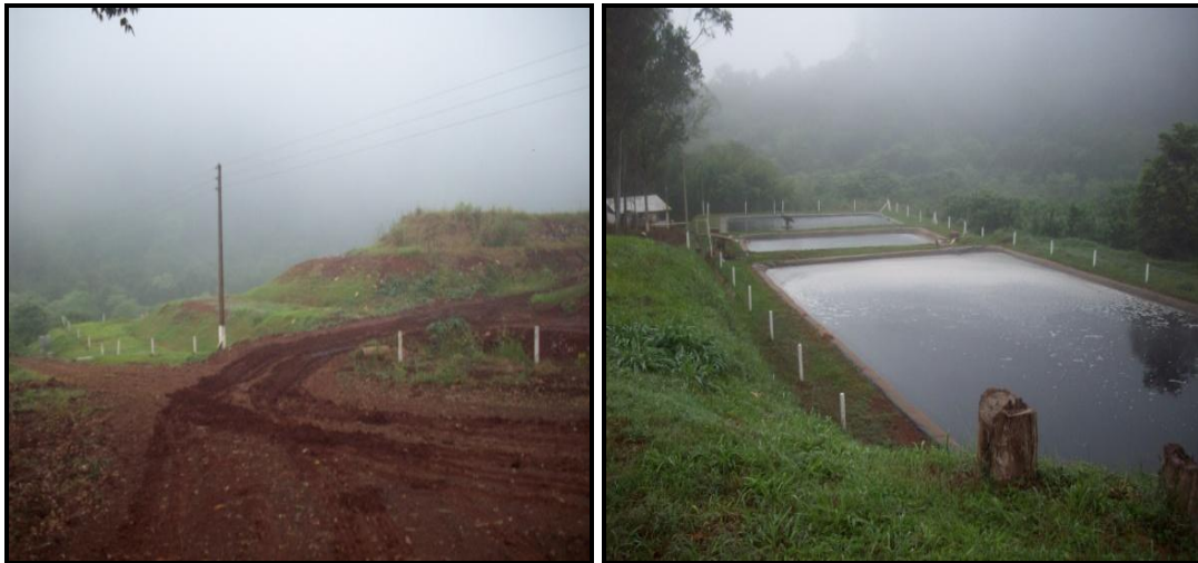
Figura 11: Aterro Sanitário Unidade I Saudades – SC.
