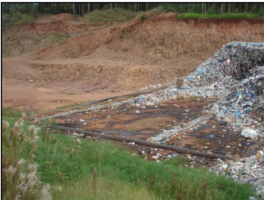
Figura 26: Sistema de drenagem de líquidos percolados
