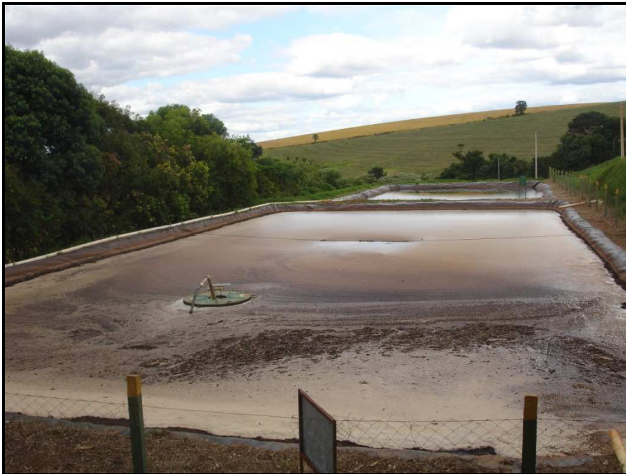
Figura 27: Sistema de tratamento de líquidos percolados
