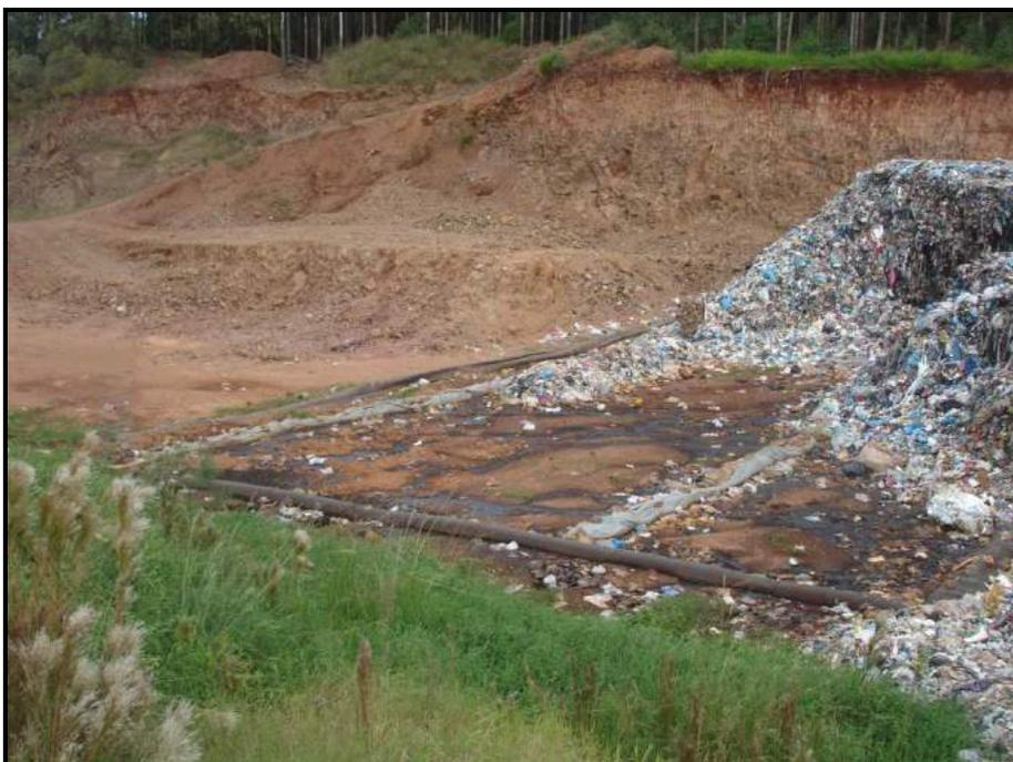
**Figura 26: Sistema de drenagem de líquidos percolados**
